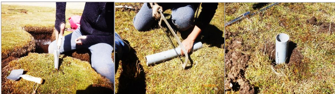
Figura 11. Instalación de piezómetros. Fuente: Elaboración propia.
