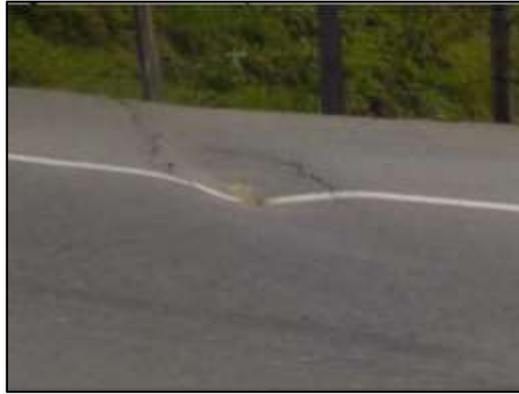
Figura 2 Hundimiento representada por el hoyo en la línea blanca.
