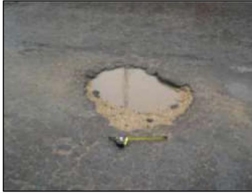
*Figura 12 Ejemplo de una desintegración por baches.*
