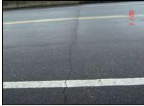
*Figura 7 La línea que se observa corresponde a una fisura transversal*
