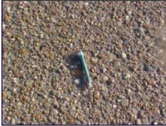
Figura 11 Falla tipo desintegración por peladura.
