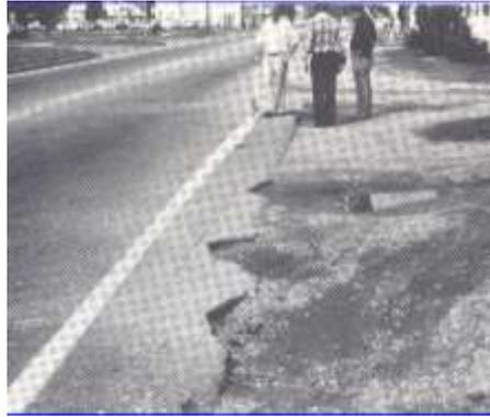
Figura 13 Los trozos faltantes en la pista corresponde a una desintegración de bordes
