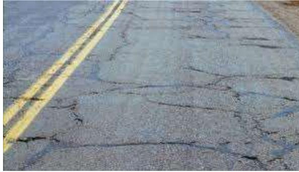
Figura 8 La fisura en bloque están representadas por transversales y longitudinales.
