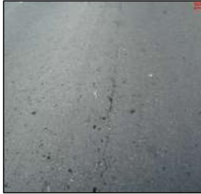
*Figura 6 Línea en dirección a la vía es denominada fisura longitudinal.*
