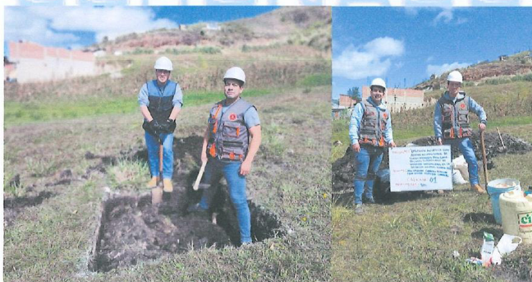
FOTOGRAFÍA N° 02: Excavación y extracción muestras de suelo de Calicata N° 01
