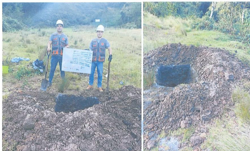
FOTOGRAFÍA N° 05: Excavación y extracción muestras de suelo de Calicata N° 04
