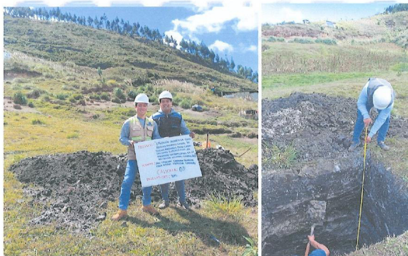
FOTOGRAFÍA N° 06: Excavación y extracción muestras de suelo de Calicata N° 05
