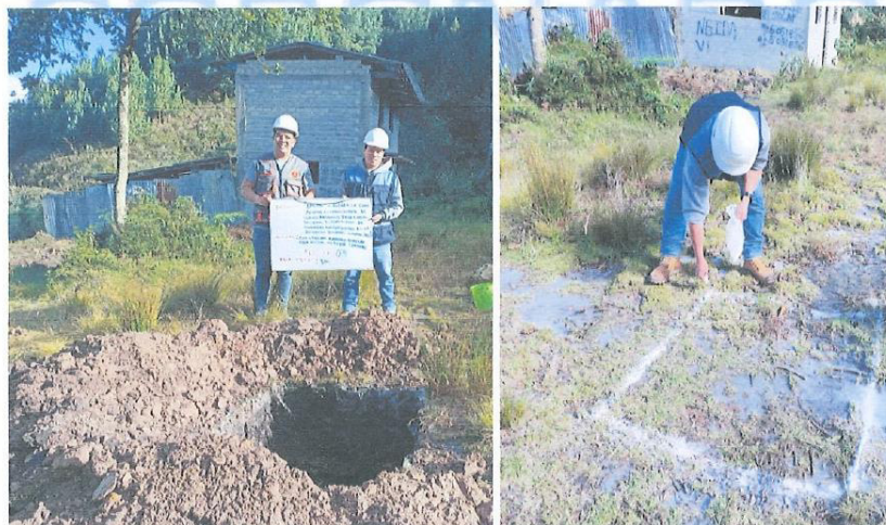
FOTOGRAFÍA N° 04: Excavación y extracción muestras de suelo de Calicata N° 03
