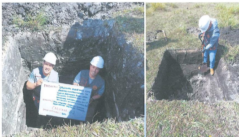
FOTOGRAFÍA N° 03: Excavación y extracción muestras de suelo de Calicata N° 02
