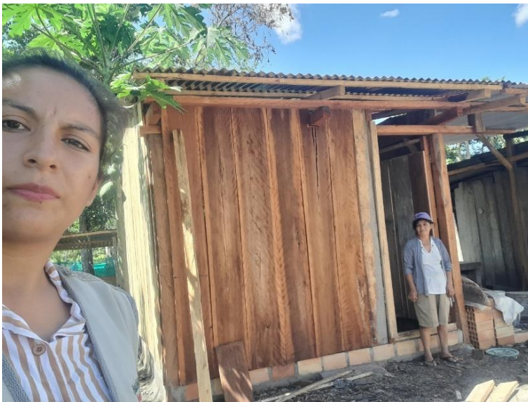
Anexo 5 Proceso de construcción del galpón para cuyes.
