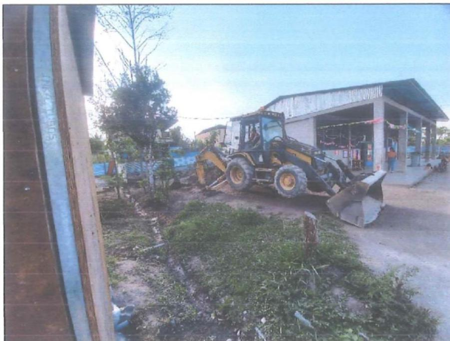
*Fotografía 1. Se realizó las excavaciones de las calicatas con maquinaria retro excavadora, esta excavación nos permite una observación directa del suelo.*
