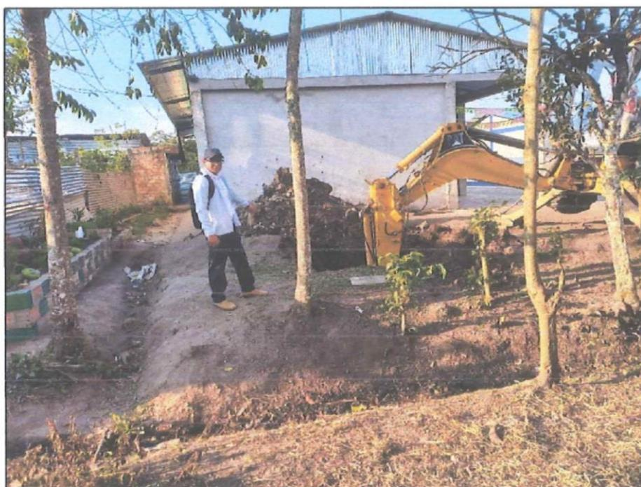
*Fotografía 2. Se observa al tesista presenciando el proceso de excavación de la calicata N° 01.*
