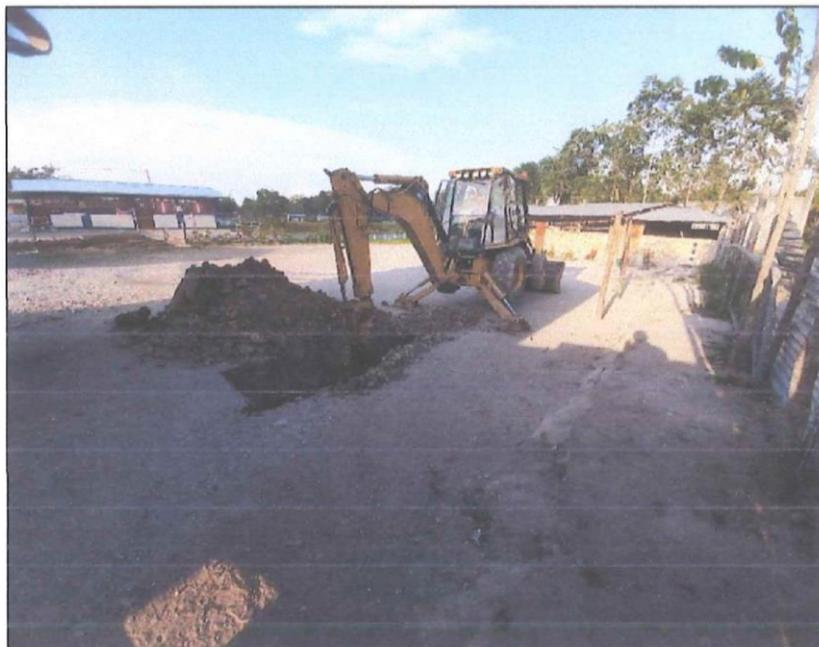
*Fotografía 4. Se realizó la excavación de la calicata N° 02 con maquinaria retro excavadora, esta excavación nos permite una observación directa del suelo.*
