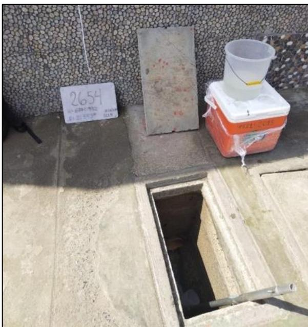
*Nota.* Fotografía del buzón de descarga final y extracción de muestra de agua residual del restaurante Ya Pez Gringo. Elaboración propia.
