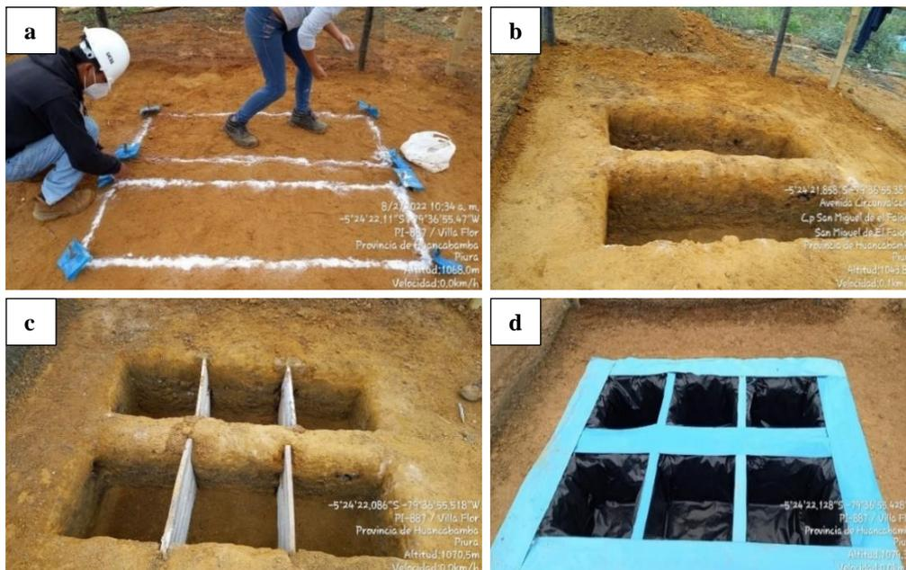
*Nota.* **a.** Dimensionamiento, **b.** Excavación, **c.** División y **d.** Impermeabilidad.
