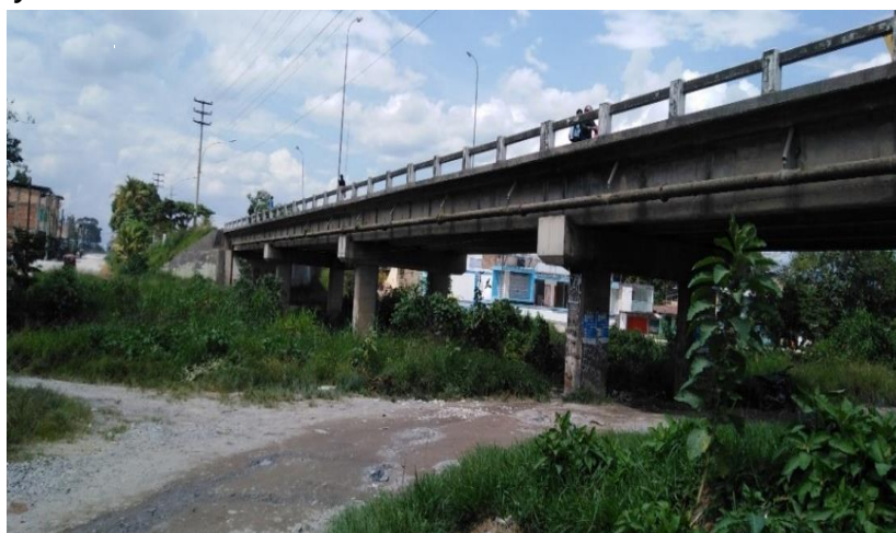
Figura 2 Puente Yuracyacu – año 2023.
