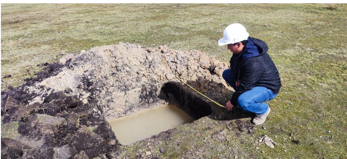
Fotografía 6. Medición de la calicata realizada.
