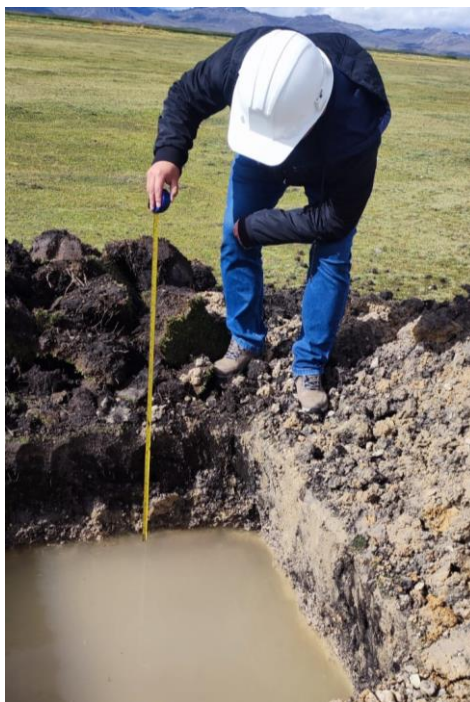
Fotografía 7. Medición del nivel freático de la calicata 2.
