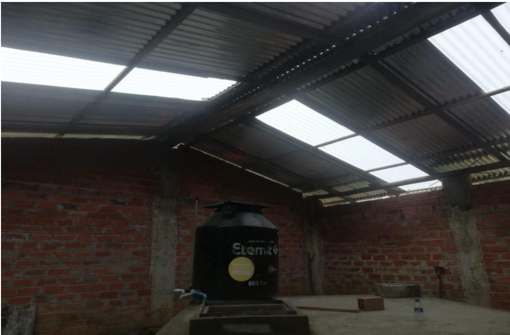
ANEXO 16: Techado de Reservorio
