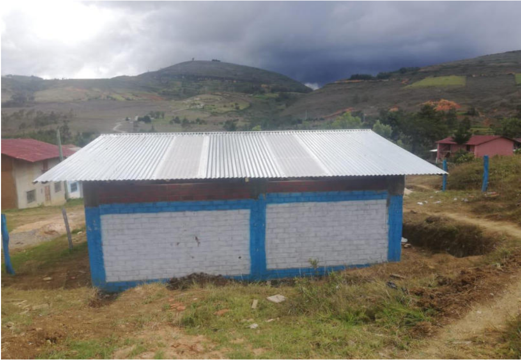
ANEXO 15: Techado de Reservorio
