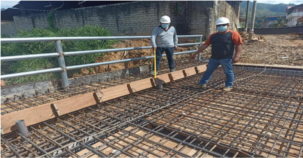
Anexo 6: Vista panorámica del vaciado de concreto en la losa del puente
