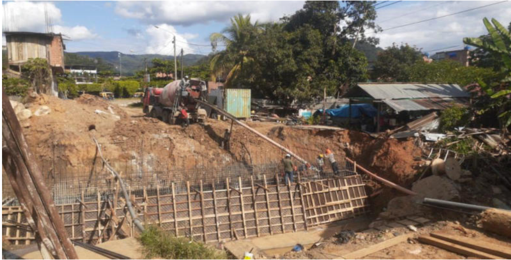
Anexo 4: Vista de la armadura de acero de la viga principal
