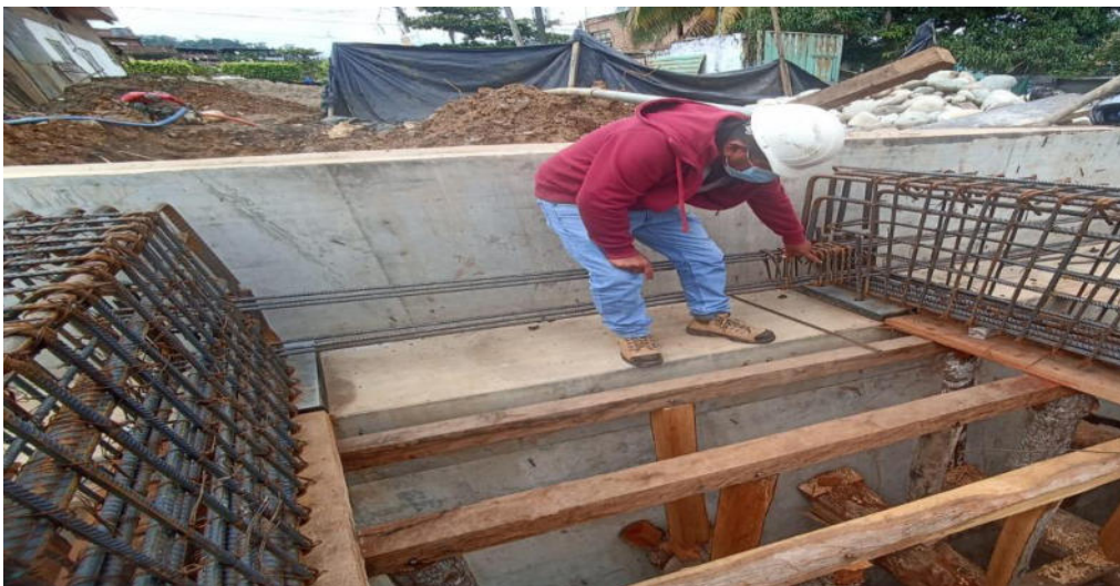
Anexo 4: Vista de la armadura de acero de la viga principal
