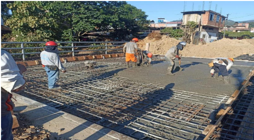
Anexo 6: Vista panorámica del vaciado de concreto en la losa del puente
