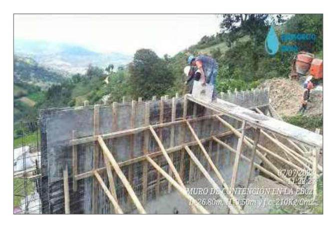
Nota. Ejecución de partidas de encofrado y concreto f'c=210kg/cm2 para muro de contención L=26.80m
