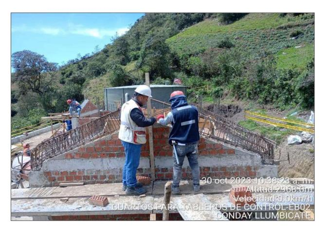
*Nota*. Ejecución de partidas encofrado y habilitación de acero para techo en cuarto de tableros de control.
