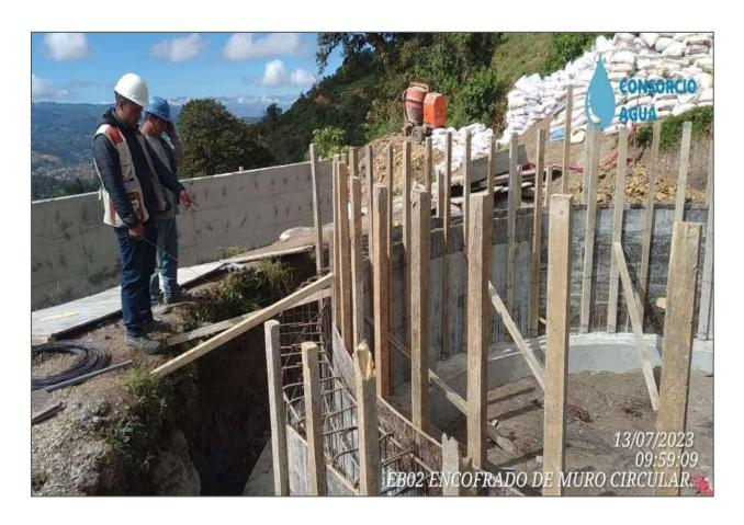
*Nota.* Ejecución de partidas de encofrado y concreto f'c=280kg/cm² para anillo circular para la estación de bombeo 02 (EB02-V=115M3)
