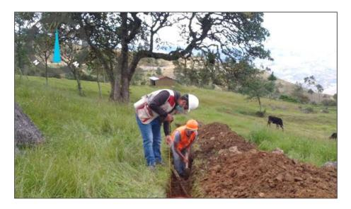
Nota. Excavaciones de zanjas en terreno normal para redes de distribución.
