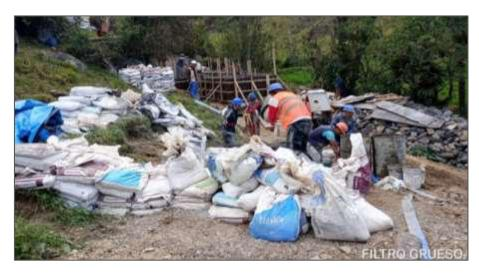
Nota. Ejecución de partidas de encofrado y concreto f'c=280kg/cm² para el filtro grueso
