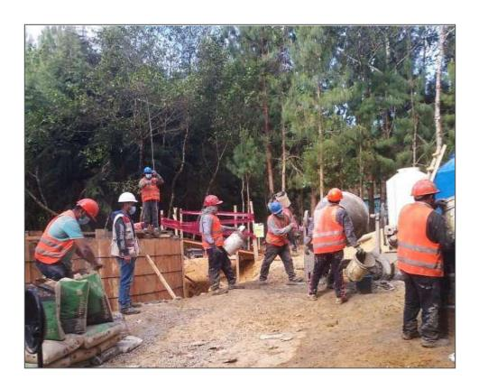
Nota. Ejecución de partidas de concreto f'c=280kg/cm<sup>2</sup> en reservorios
