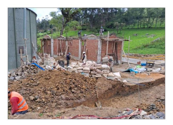
Nota. Ejecución de partidas en la Estación de Bombeo 01-Tanque metálico tipo australiano Asimismo, se verificaron los procesos constructivos de la estructura para cuartos de tableros de control según los planos para que no obviar alguna partida (figura 9).
