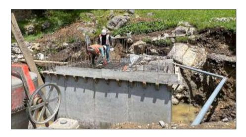
*Nota*. Ejecución de partidas de encofrado, acero fy=4200kg/cm² y concreto f'c=280kg/cm² para la captación el ojo de agua
