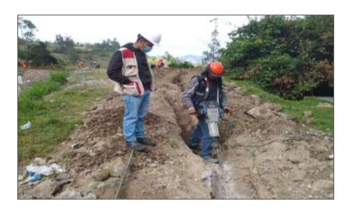
Nota. Excavaciones de zanjas en terreno rocoso y semirrocoso para redes de distribución.
