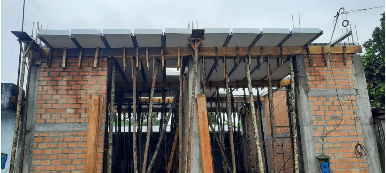
Colocacion de EPS en vigas principales
