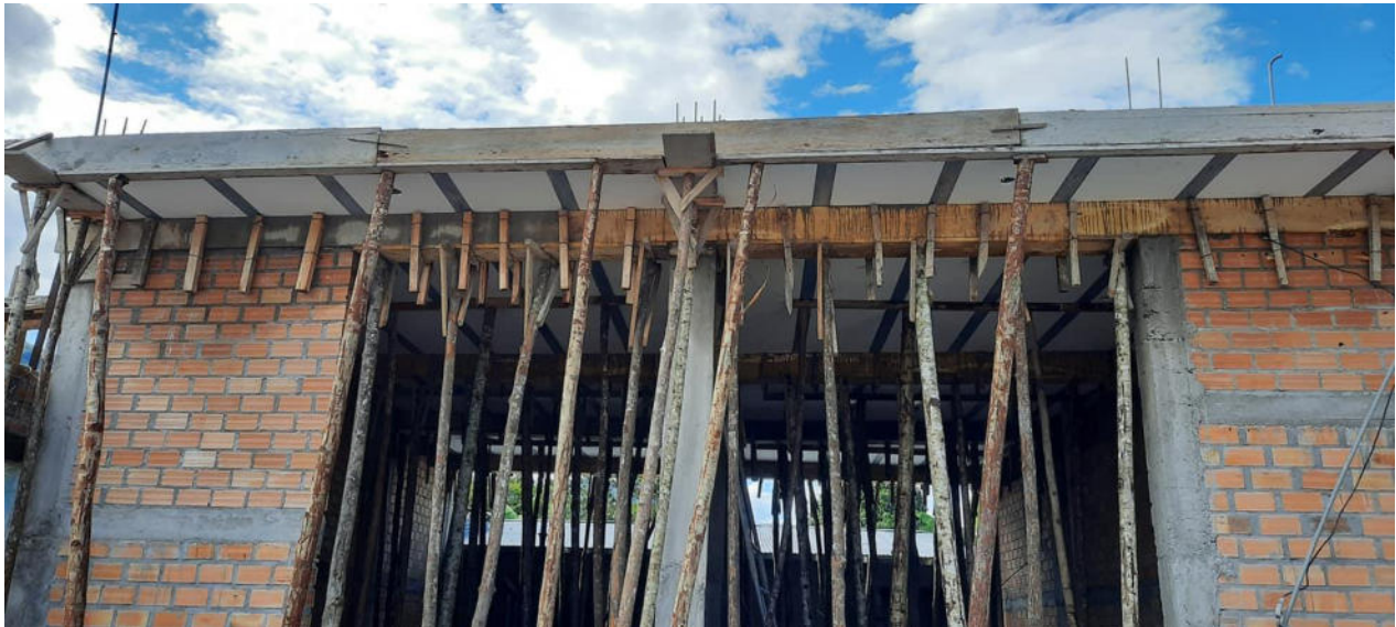
. Colocacion de frisos en losa y apuntalamiento en losa
