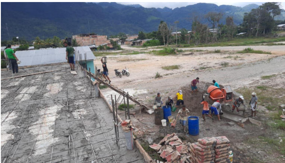
Imagen del proceso de vaceo de techo vigacero
