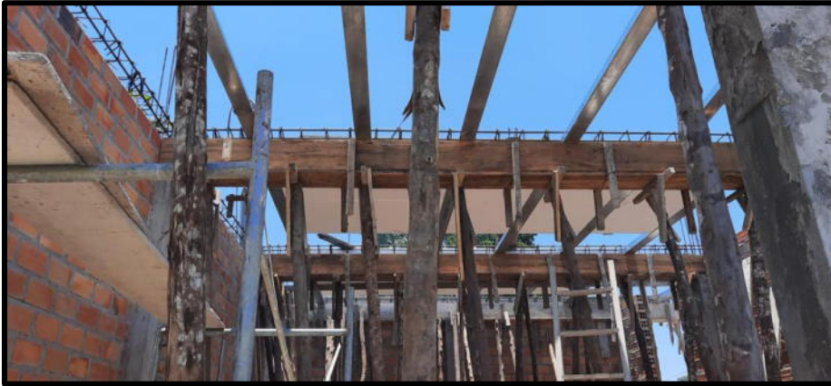
Colocación de viguetas vigacero
