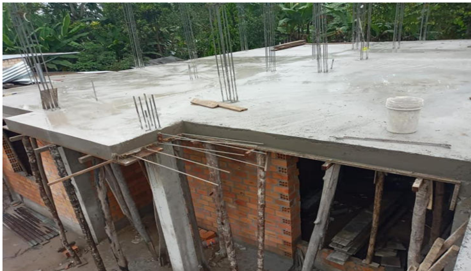
Vaceado de concreto de losa aligerada sistema vigacero
