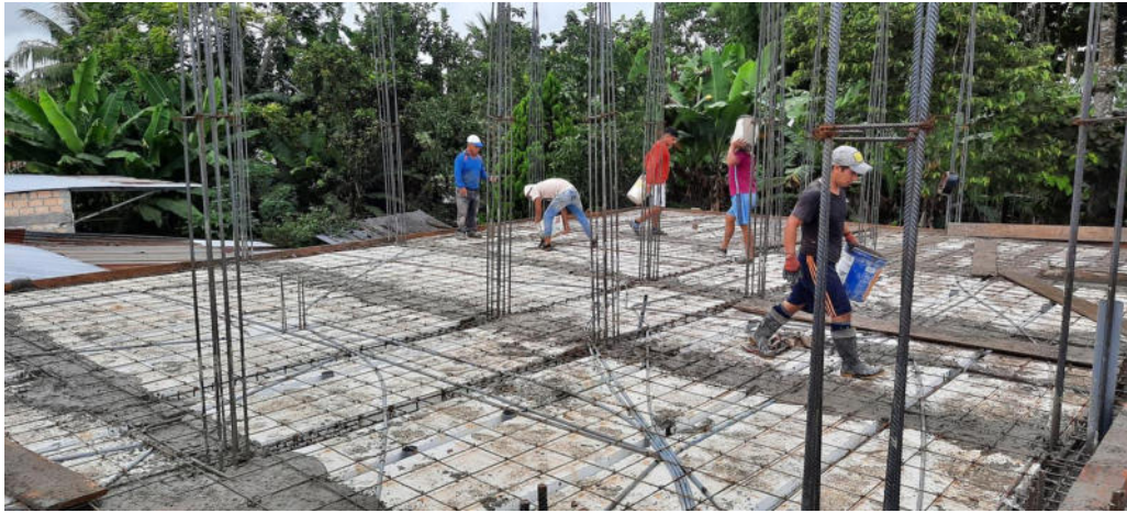
Vaceo de concreto en vigas y losa vigacero
