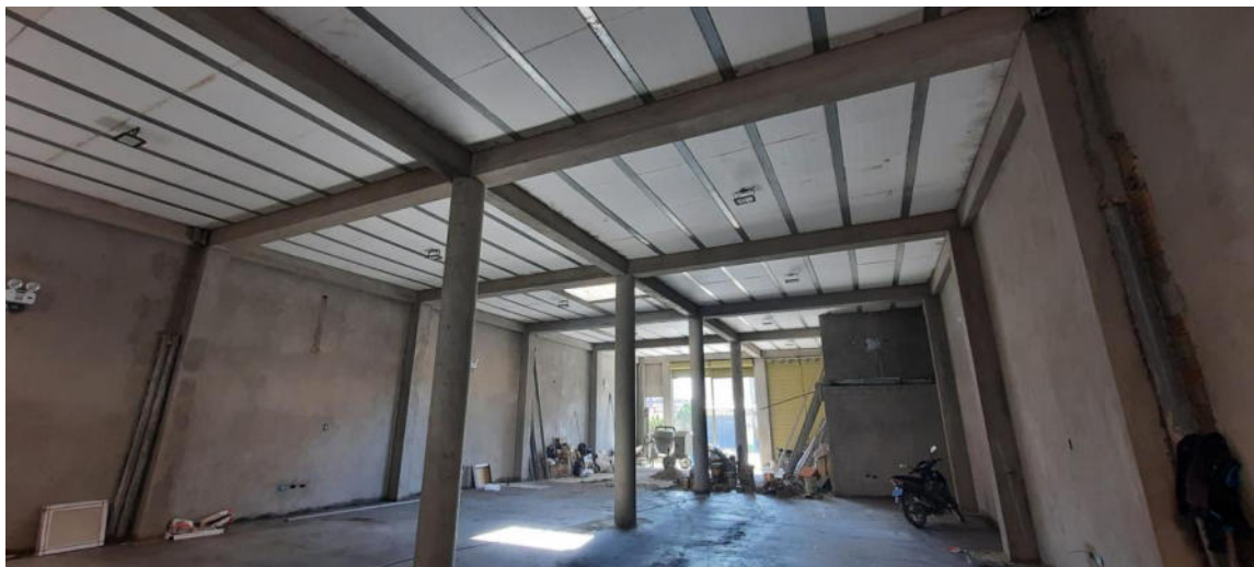
Vaceado de concreto de losa aligerada sistema vigacero
