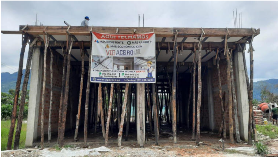
Imagen de techo ejecutado con sistema vigacero
