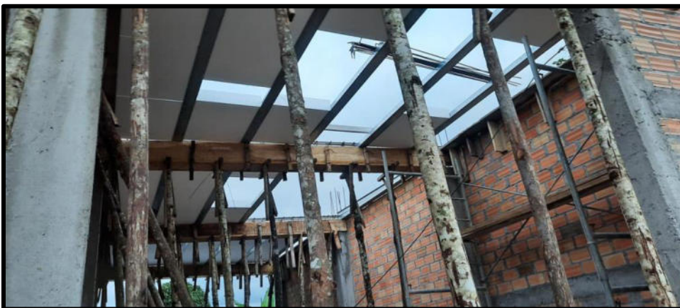
Colocación de viguetas vigacero
