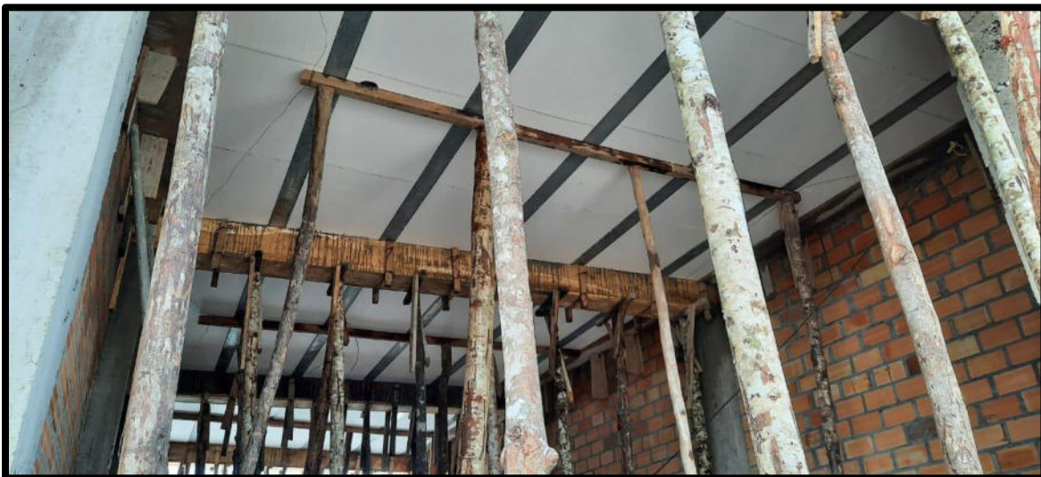
Encofrado de losa aligerada-Apuntalamiento de losa
