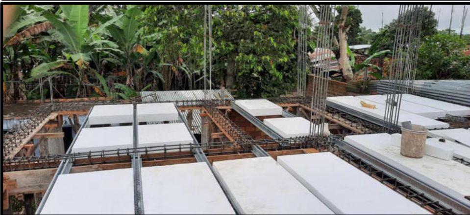
Colocacion de casetones de poliestireno
