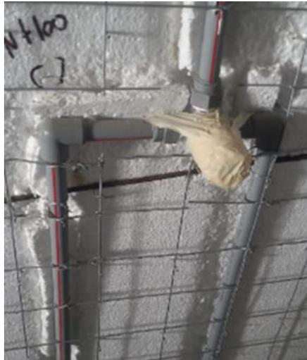
*Nota.* Instalación de las mezcladoras de ducha en los paneles de núcleo de poliestireno expandido. Elaboración propia.
