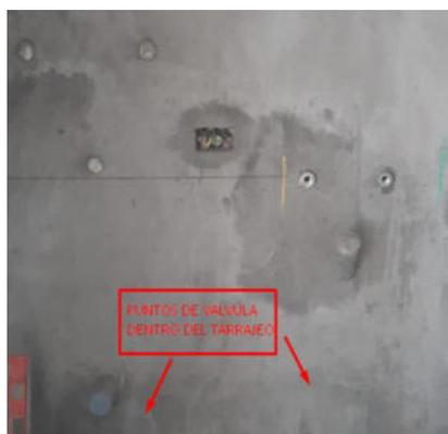
*Nota.* Salidas de agua tapadas por el tarrajeo en los paneles de núcleo de poliestireno expandido.
