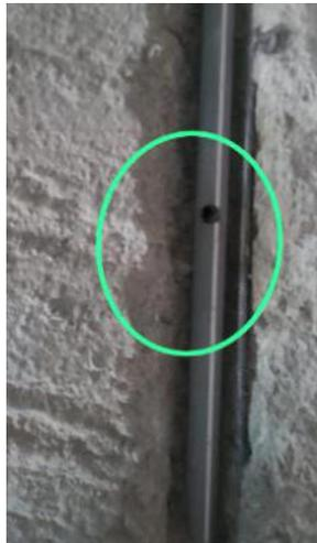
*Nota.* La tubería de agua anclada para el asentado de ladrillo silico calcáreo. Elaboración propia.
