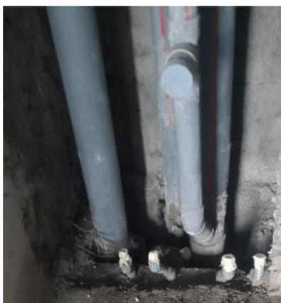
*Nota.* Tuberías de agua caliente y fría levantadas a 15 cm, asimismo las tuberías de desagüe según fichas técnicas. Elaboración propia.
