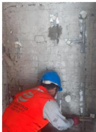
*Nota.* Fijación de puntos de agua sobresalida o tapados por el proyectado en los paneles. Elaboración propia.
