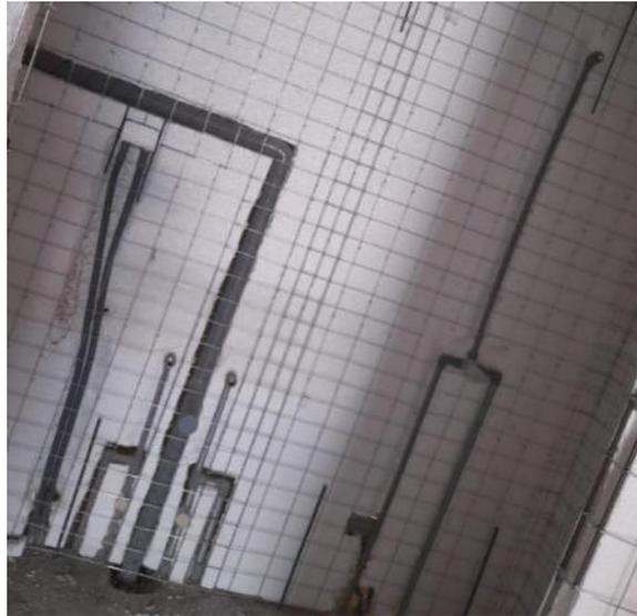
*Nota.* Levantamiento de salidas de agua e instalación de válvulas en los paneles de núcleo de poliestireno expandido. Elaboración propia.
