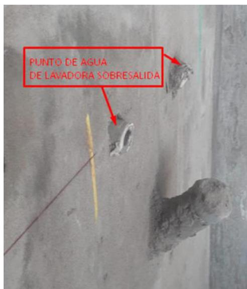
*Nota.* Puntos sobresalidos y torcidos en paneles de núcleo de poliestireno expandido. Elaboración propia.
