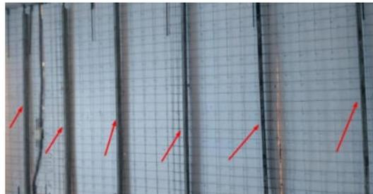
*Nota.* Colocación de las reglas en los paneles detrás de los puntos sanitarios para la fijación de las salidas de agua. Elaboración propia.
