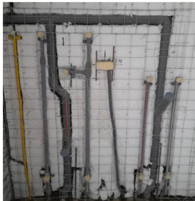
*Nota.* Puntos de agua fría y caliente fijado en los paneles para una lavandería. Elaboración propia.
