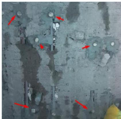
*Nota.* Fijación de puntos de agua torcidos o tapados por el mortero del proyectado en los paneles. Elaboración propia.
