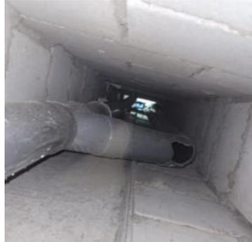
*Nota.* Codo de montante de desagüe roto por caída de retazo de ladrillo. Elaboración propia.
