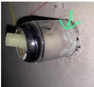
*Nota.* En la figura se observa el panel tarrajado y la mezcladora desprotegida, así pues, rayada.
