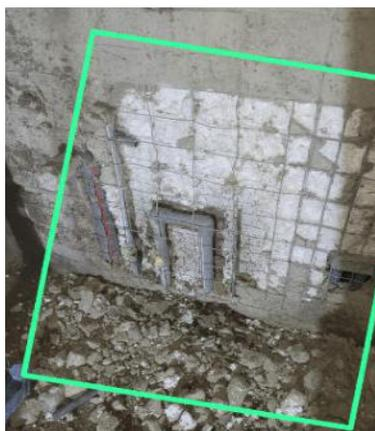
*Nota.* Tuberías de agua fría y caliente sobresalidas en panel de núcleo de poliestireno expandido.
