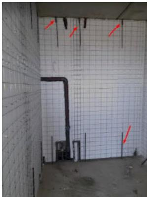
*Nota.* La figura muestra los paneles divisores ya instalados en un ambiente de un baño, se puede apreciar el anclaje que soporta a los paneles. Elaboración propia.
