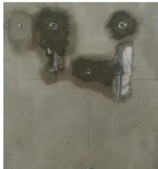
*Nota.* Fijación de puntos de agua torcidos o tapados por el tarrajeo en los paneles.
