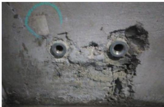
*Nota.* Puntos de agua torcidos y sobresalidos por el tarrajeo de los paneles de núcleo de poliestireno expandido. Elaboración propia.
