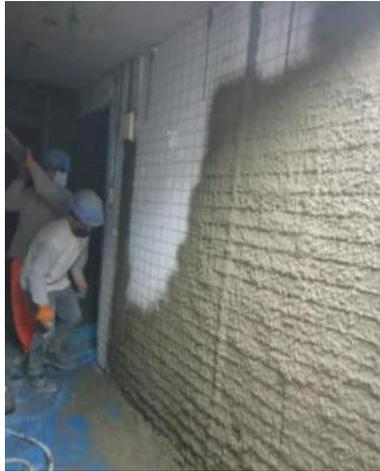
*Nota.* En la figura se observa el proceso del proyectado en los paneles de núcleo de poliestireno expandido. Elaboración propia.
