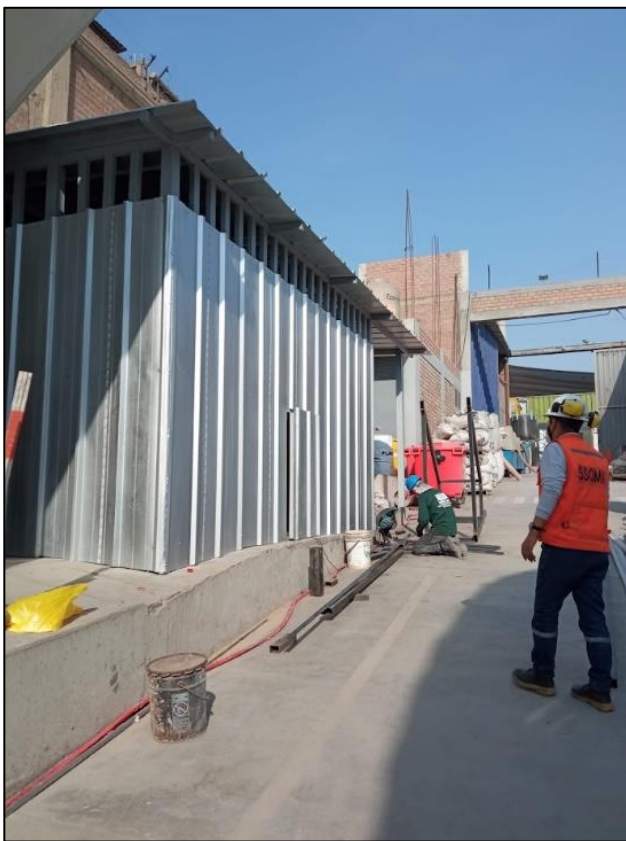
Almacén de residuos sólidos
