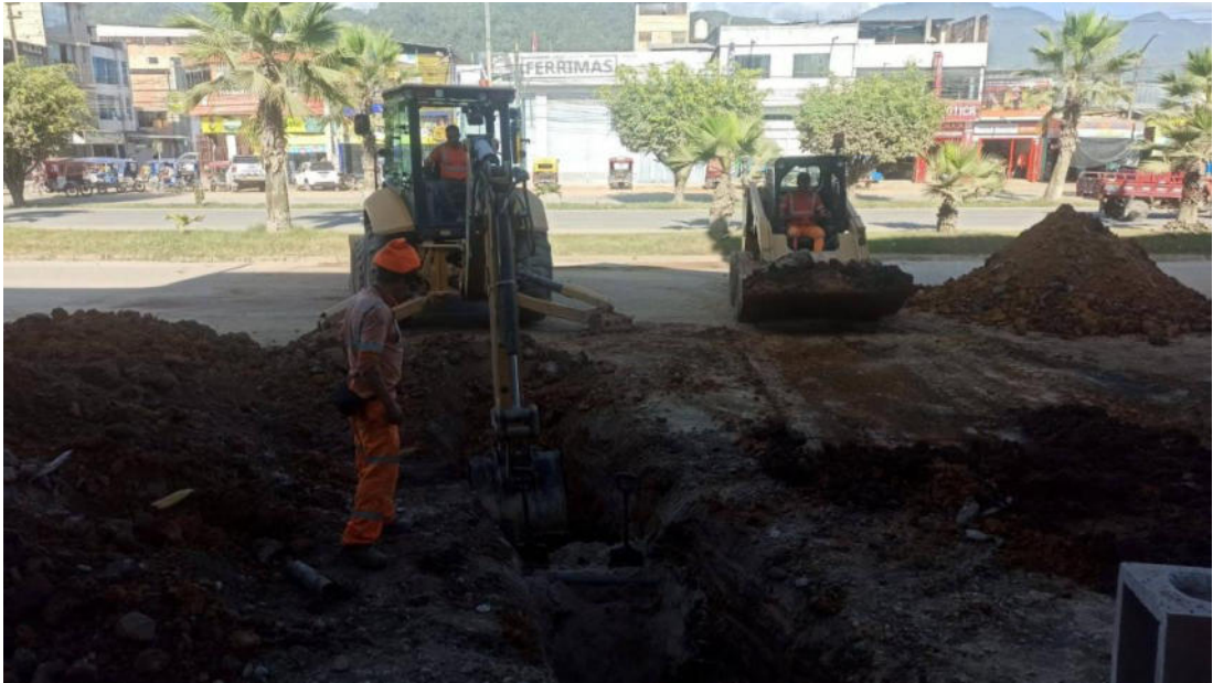
Figura 9 Instalación de tubería de agua y desagüe de la red hacia la vereda
