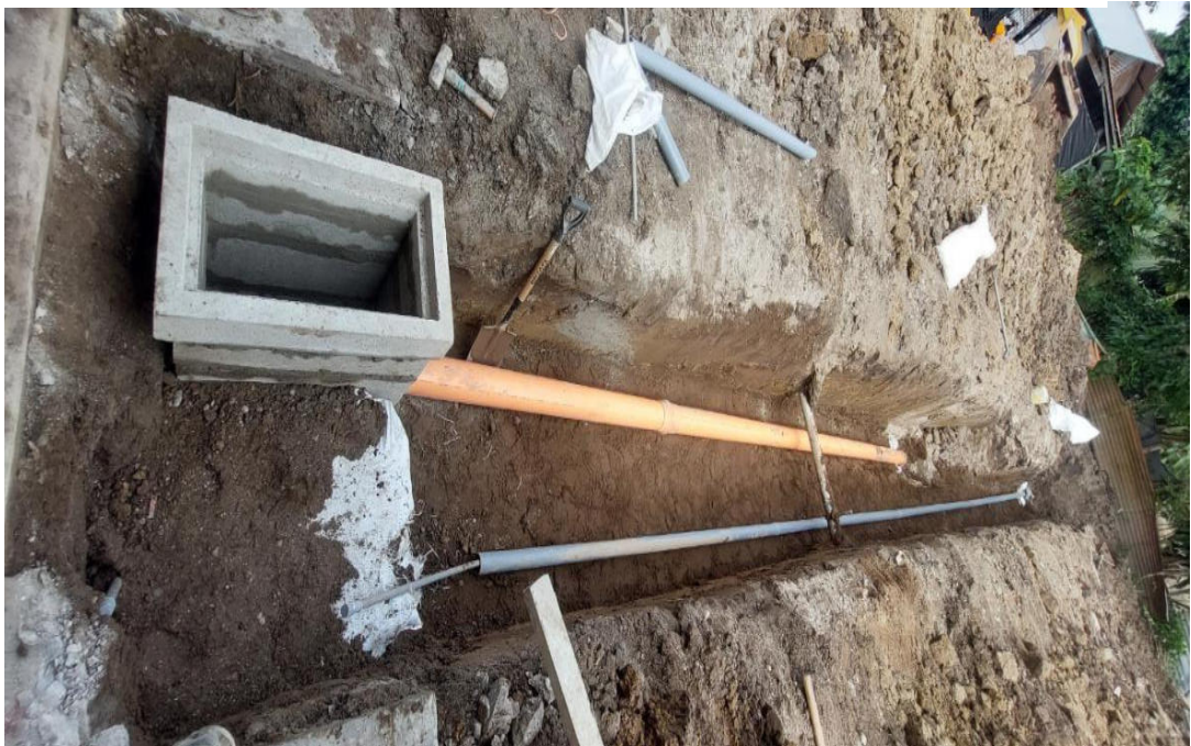
Figura 9 Instalación de tubería de agua y desagüe de la red hacia la vereda
