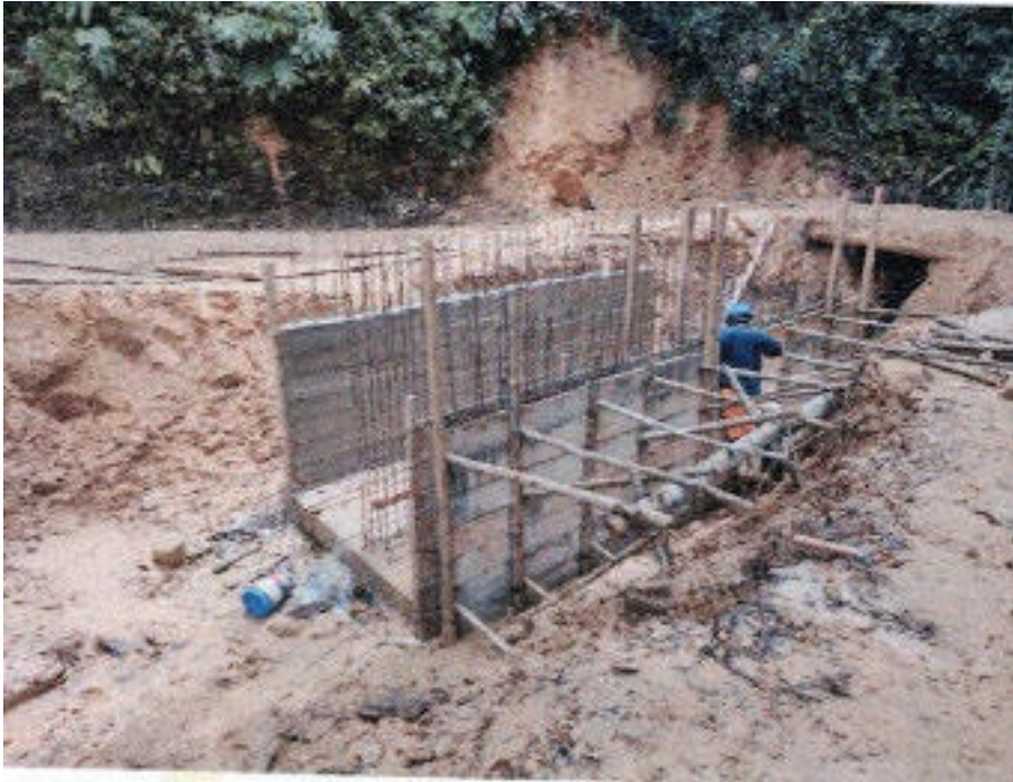
Fotografía 03: habilitado de acero corrugado y encofrado
