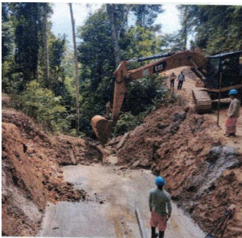
Fotografía 01: excavaciones con maquinaria pesada para pontón
