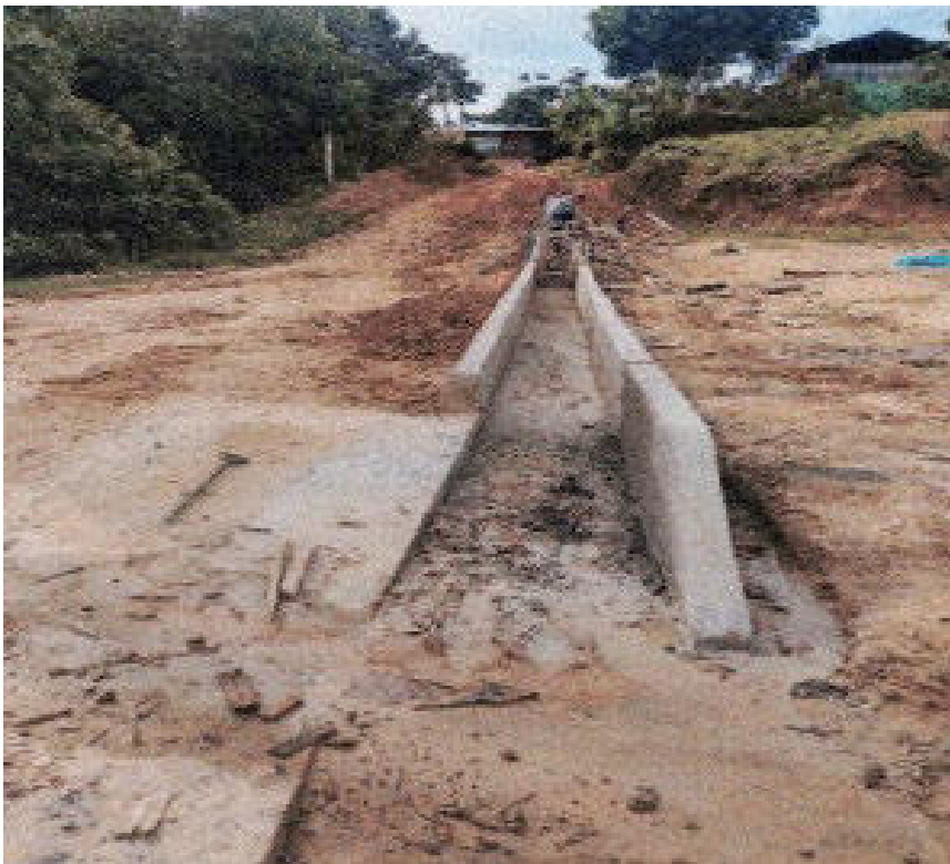
Fotografía 10: culminación del trabajo en las cunetas, parte del adicional de obra
