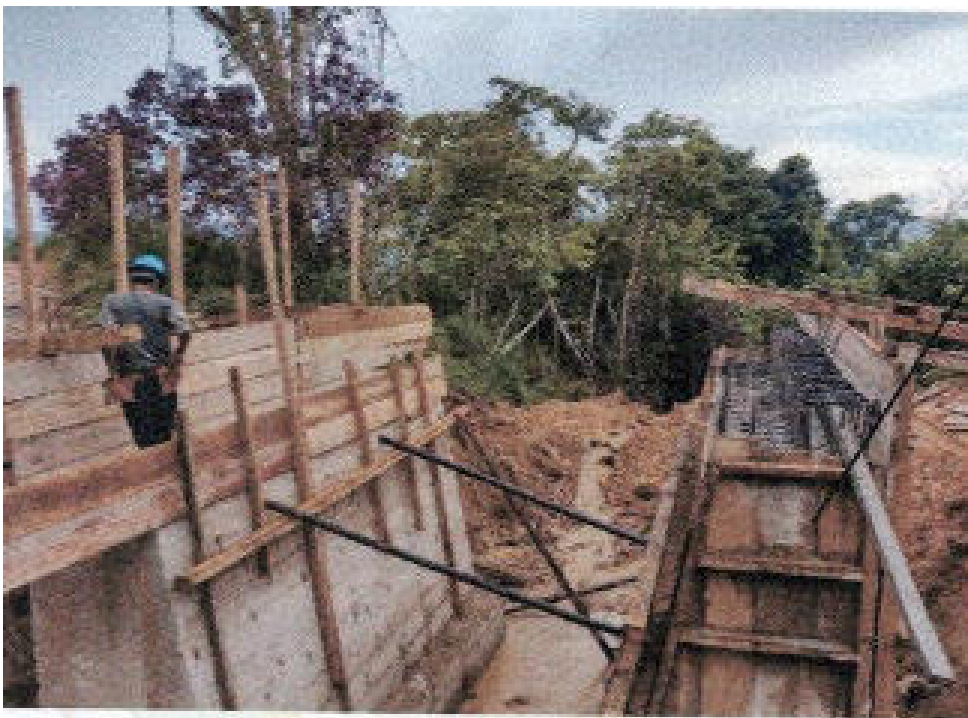
Fotografía 04: desencofrado de los muros del pontón
