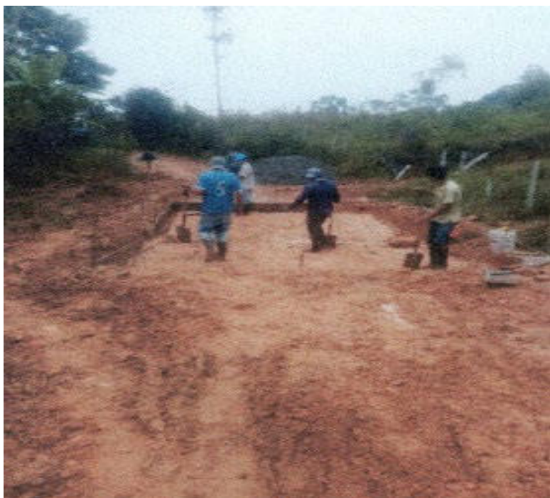
Fotografía 02: excavación manual para badén
