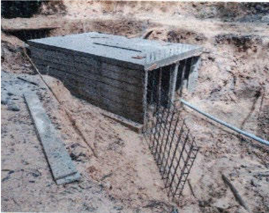
Fotografía 05: se visualiza la alcantarilla desencofrada y la armadura de las aletas
