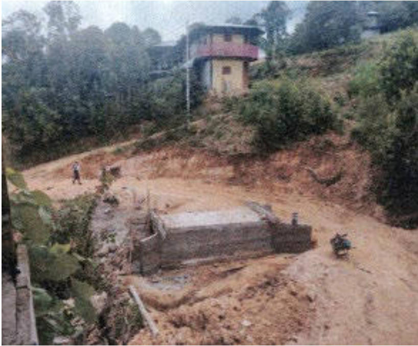
Fotografía 09: desencofrado de la alcantarilla de dos ojos
