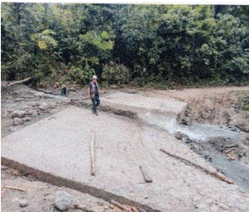
Fotografía 06: se visualiza la culminación del baden
