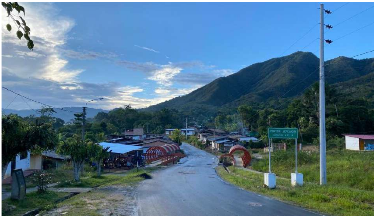
Figura 48. Vista de un pontón construido recientemente que une a los barrios La Unión y San Juan del Arenal en el Jr. Moyobamba.
