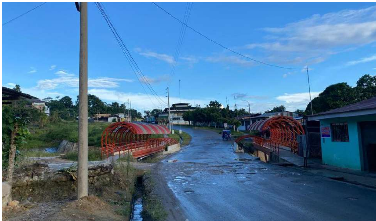
Figura 26. Vista del Jr. Moyobamba ubicado en el barrio La Unión (Zona 1).
