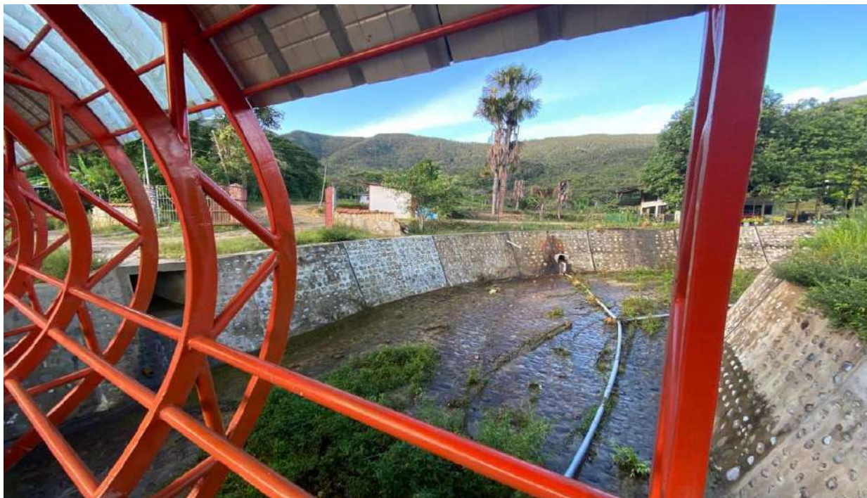
Figura 34. Vista de una defensa ribereña construida en el cauce de la quebrada Disiyacu. Fuente: Toma personal, 2021.
