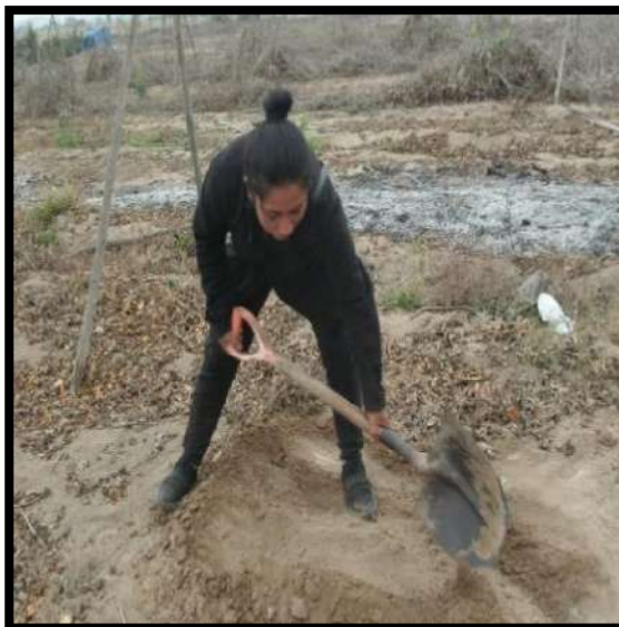
Fotografía 9. Rellenado de la calicata después de la descripción
