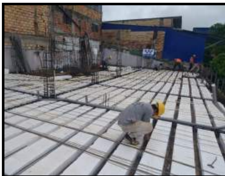
Figura 24: Instalación de bloques de tecnopor
