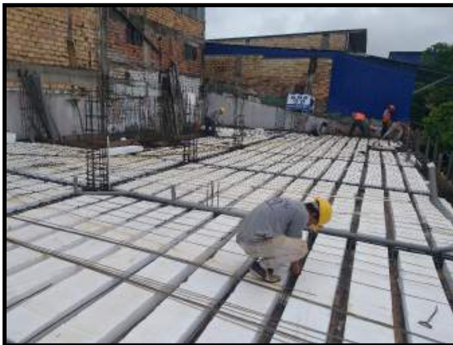
Figura 23: Instalación de Bloques de Tecnopor y Acero de Temperatura
