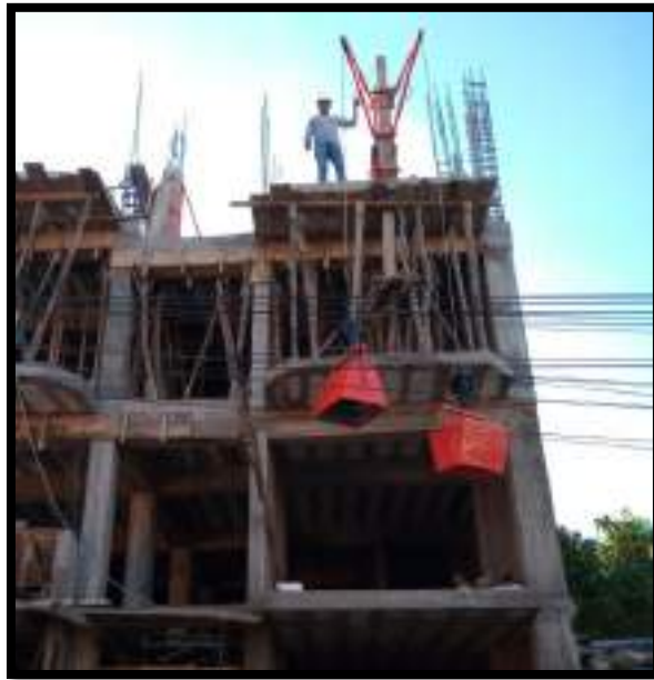
Figura 25: Winche eléctrico instalado en obra
