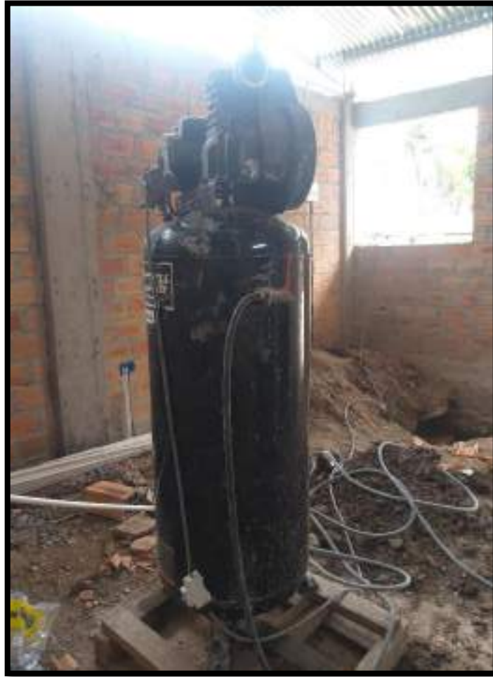
Figura 24: Compresora Utilizada Para el Tarrajeo de Muros
