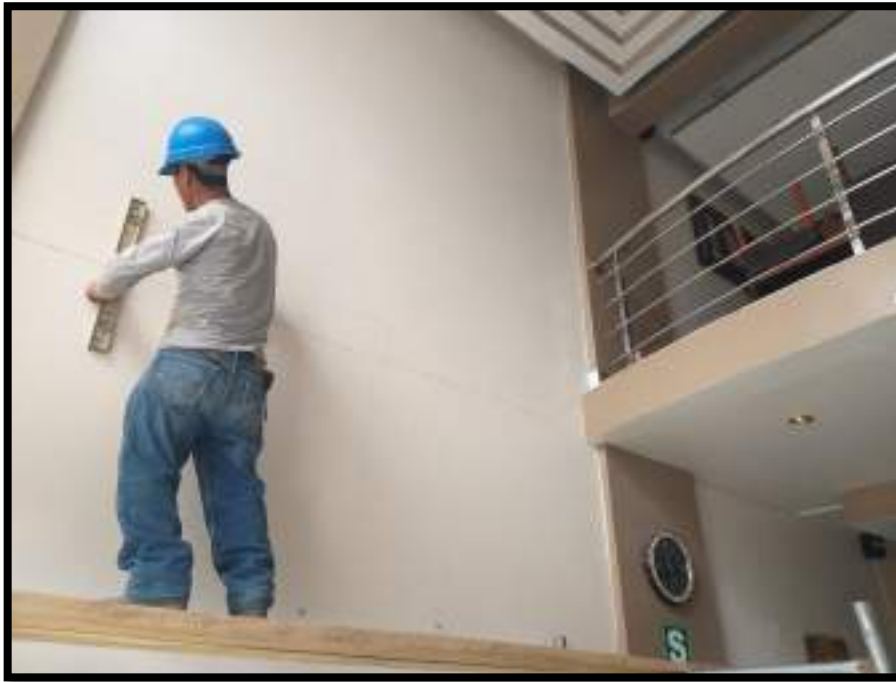
Figura 22: Trazo de Puntos con Ayuda de Proyección Láser
