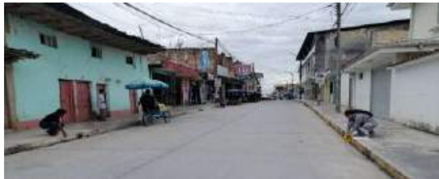
Fotografía 3: Verificación en campo del ancho de vías pavimentadas en el Jr. Julio C Arana - Barrio Quinapata
