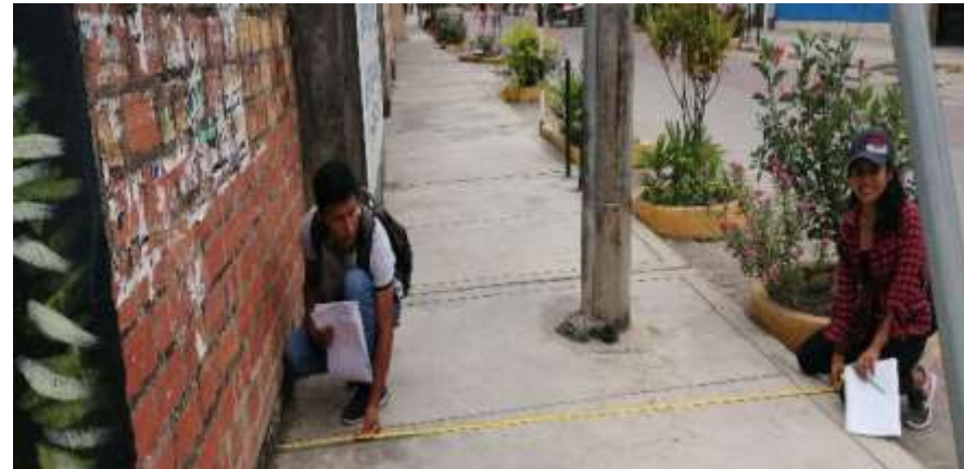
Fotografía 12: Verificando ancho de acera peatonal en el Jr. Libertad del Barrio Quinapata con estructura de concreto de 1.50 m y elemento que obstaculiza el tránsito peatonal.
