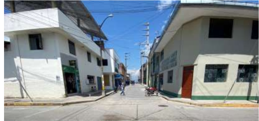
Fotografía 14: Veredas sin acceso a rampas para sillas de ruedas en vías pavimentadas, esquina del Jr. Santo Toribio y Jr. Faustino Maldonado.
