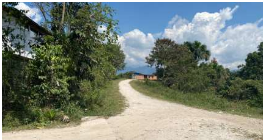
Fotografía 19: Estado actual de vía ribereña del Uquihua.
