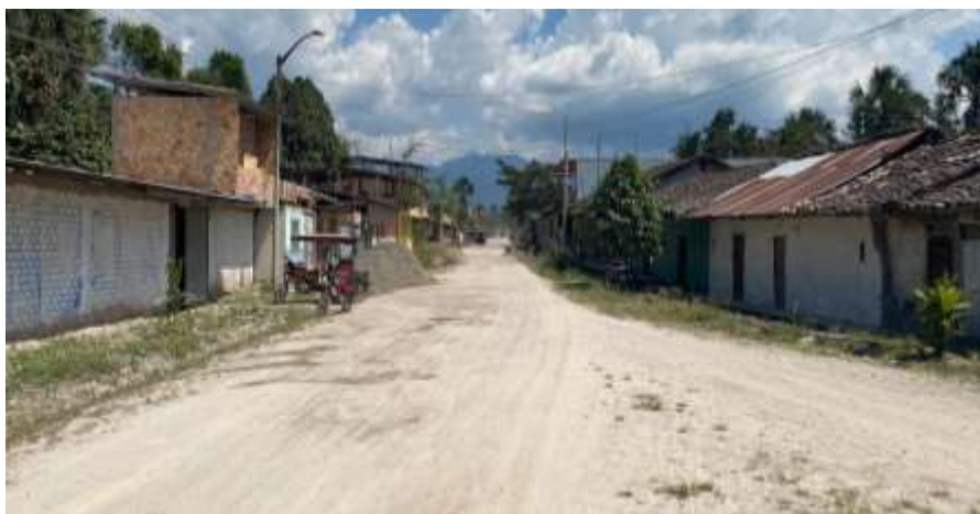
Fotografía 18: Estado actual del Jr. Pablo Mori
