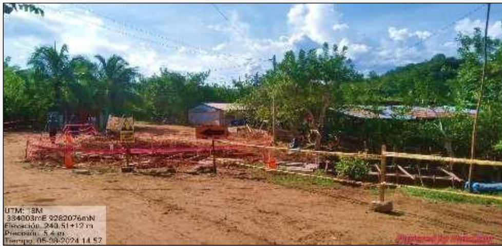
Colocación de señalización en zonas de peligro
