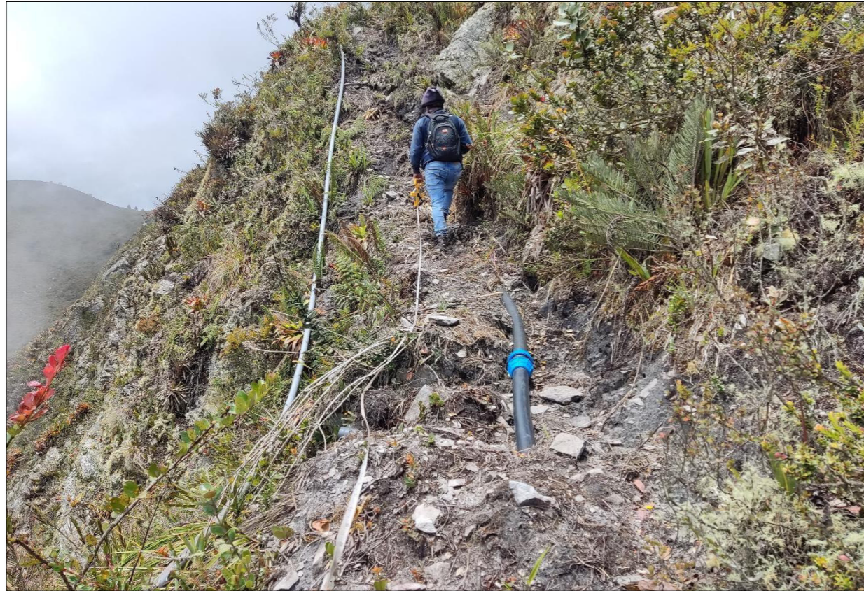
Apéndice F. Fotografías de la ejecución del Adicional N°01.
