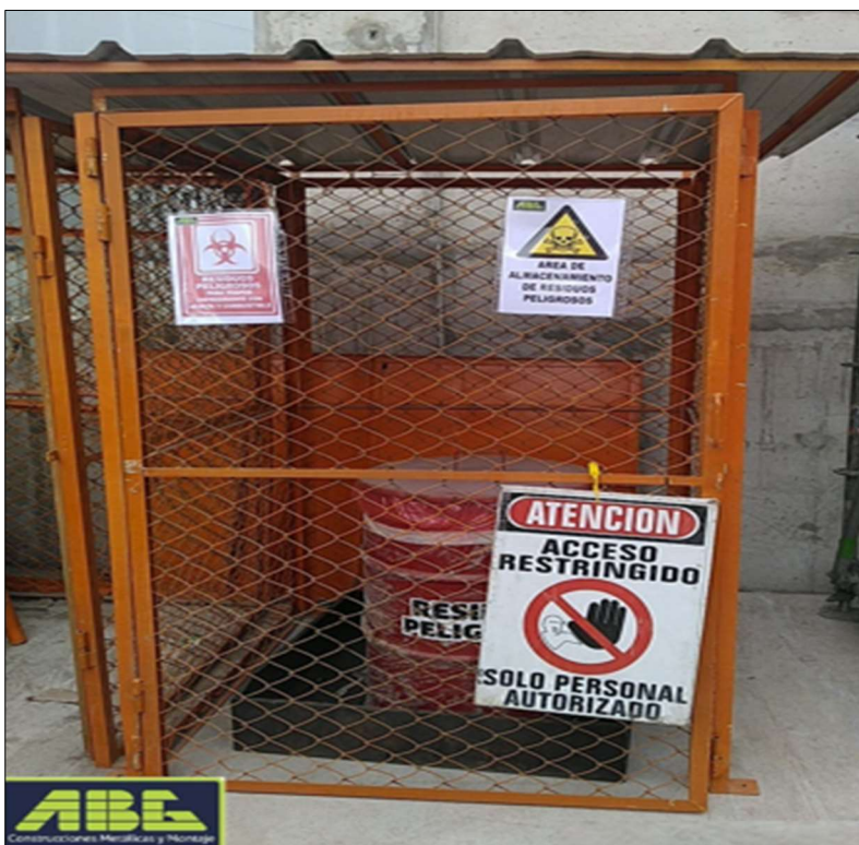
Figura 10. Almacén de residuos peligrosos.
