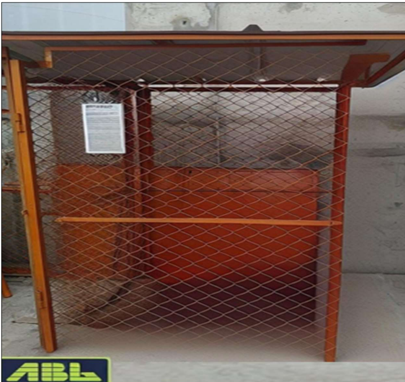
Figura 9. Adecuación del almacén de residuos peligrosos.
