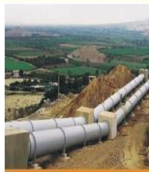
Tubería forzada enterrada - La Libertad Fuente: Chavimochic
