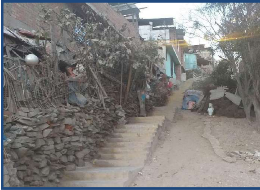
Figura 18. Viviendas construidas en pendiente
