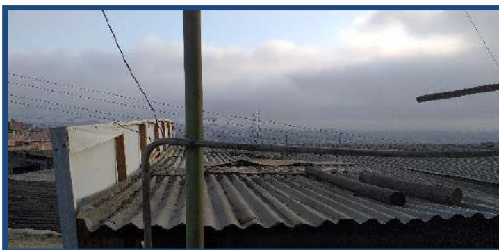
Figura 33. Cubierta de las viviendas en estudio Fuente: Propia
