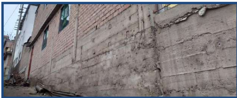
Figura 1. Cimiento ciclópeo en vivienda del AAHH en estudio
