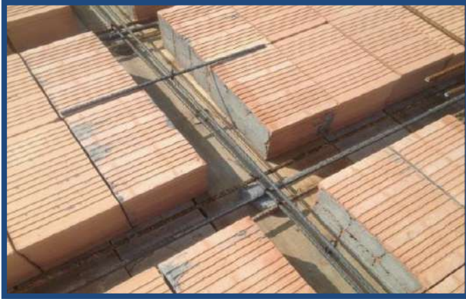
Figura 4. Losa aligerada Fuente: Propia
