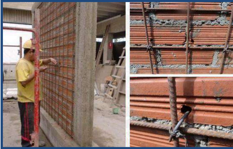
Figura 60. Instalación de la malla electrosoldada en el muro Fuente: San Bartolomé y Quiun 2012
