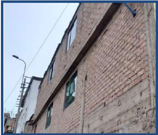
Figura 3. Muros portantes de albañilería confinada Fuente: Propia
