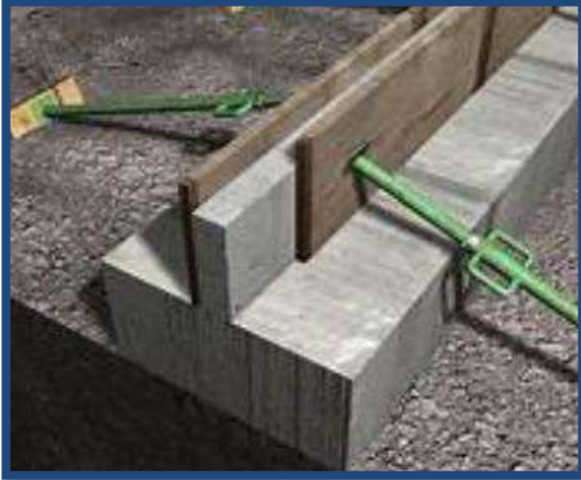
Figura 2. Sobrecimiento de las viviendas de albañilería confinada Fuente: Google
