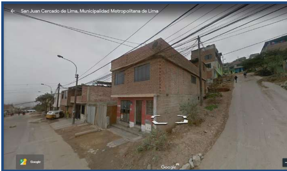
Figura 29. Vivienda que soporta fuerzas laterales del terreno Fuente: Google Earth
