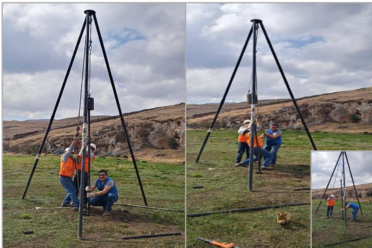
Figura 202. Hincado 03, con penetrómetro de 0.45 m. y pesa de 140 lb. ensayo SPT-01. Fuente: Elaboración Propia.
