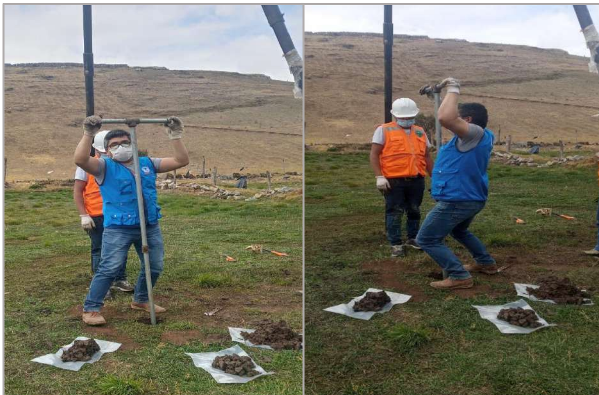
Figura 196. Sondeo con el barreno en espiral, profundidad 4.50 m, ensayo SPT-01. Fuente: Elaboración Propia.
