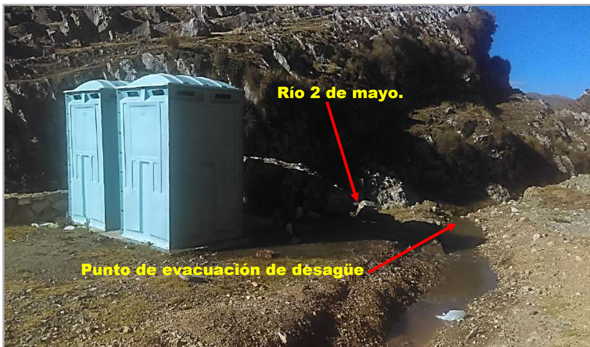
Figura 188. Punto de vertimiento de aguas residuales. Fuente: Elaboración Propia.
