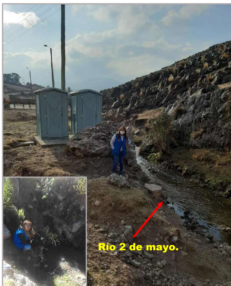
Figura 189. Inspección de vertimiento de aguas residuales. Fuente: Elaboración Propia.
