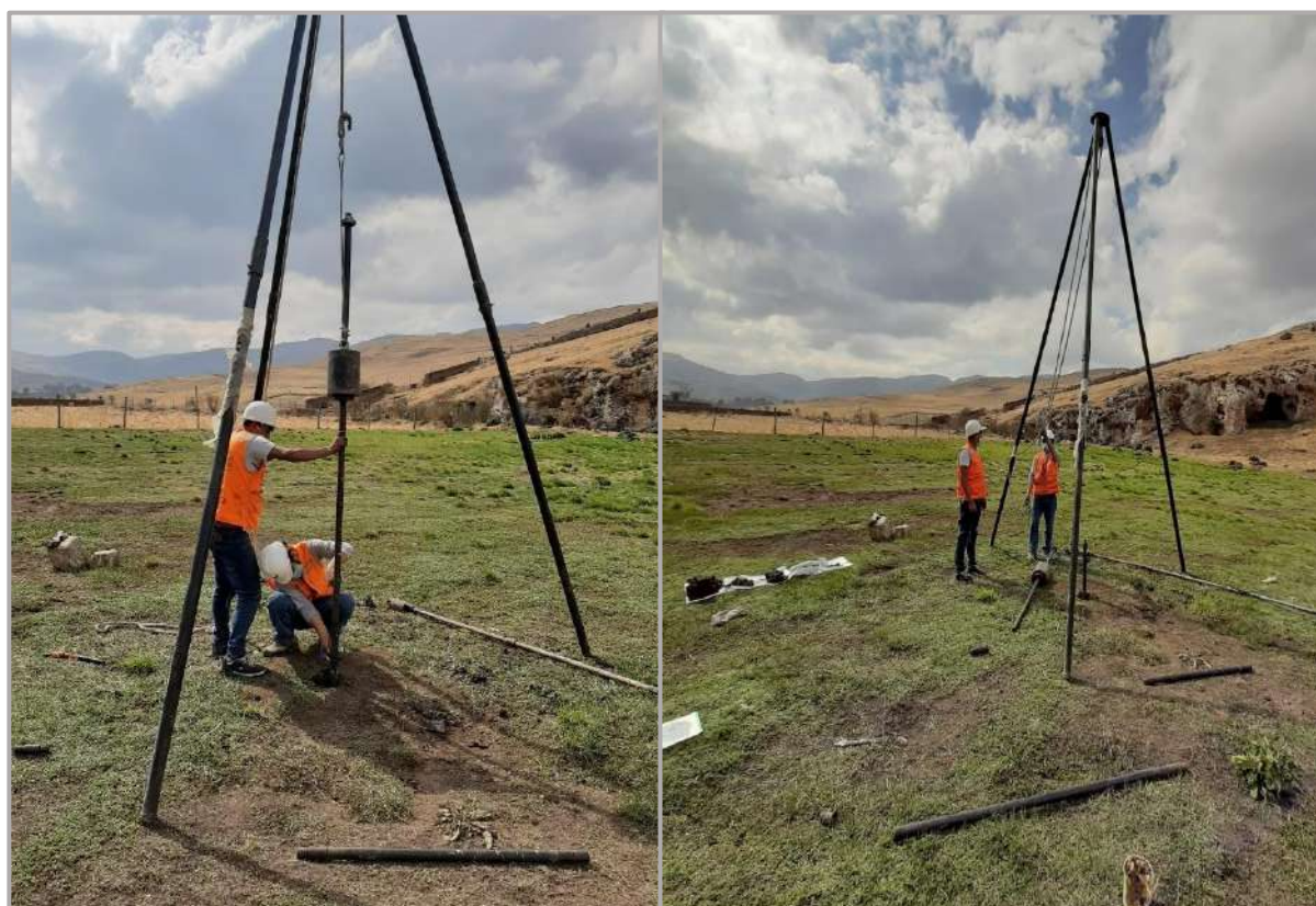
Figura 199. Instalación de pesa 140 lb, ensayo SPT-01. Fuente: Elaboración Propia.
