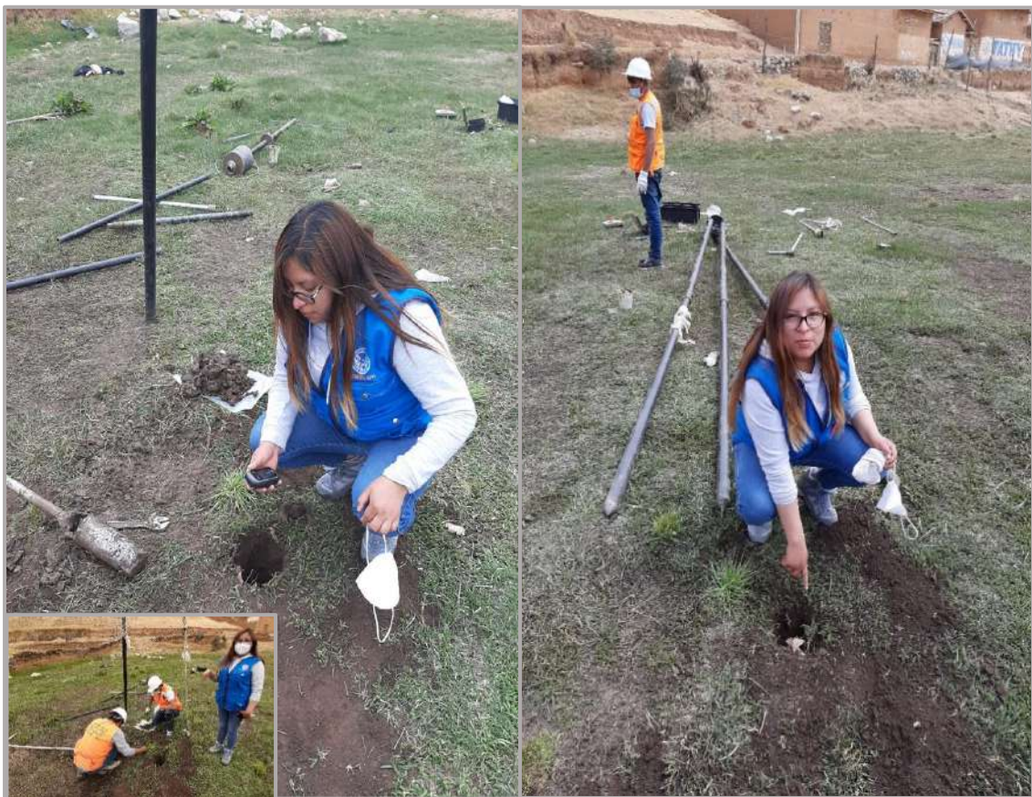
Figura 193. Ubicación de coordenadas para realizar ensayo SPT-01. Fuente: Elaboración Propia.
