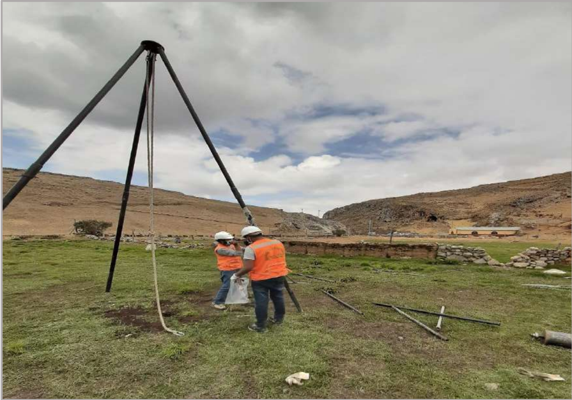
Figura 194. Instalación y centrado de trípode de carga, ensayo SPT-01. Fuente: Elaboración Propia.
