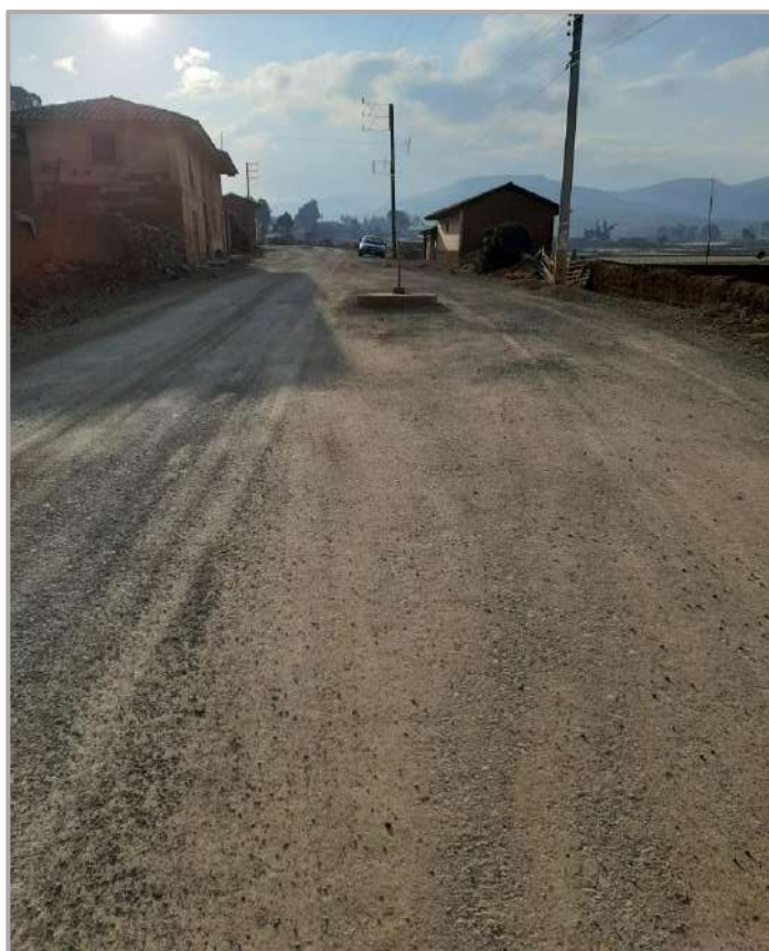
Figura 213. Ante penúltimo buzón (N° 248) ubicada al ingreso de la PTAR. Fuente: Elaboración Propia.
