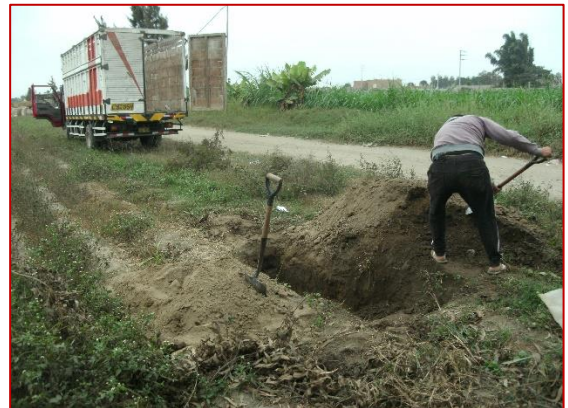
4. Rellenado de la calicata
