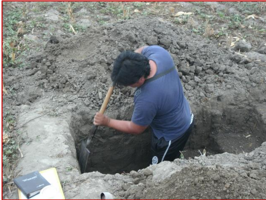
1. Construcción de la calicata
