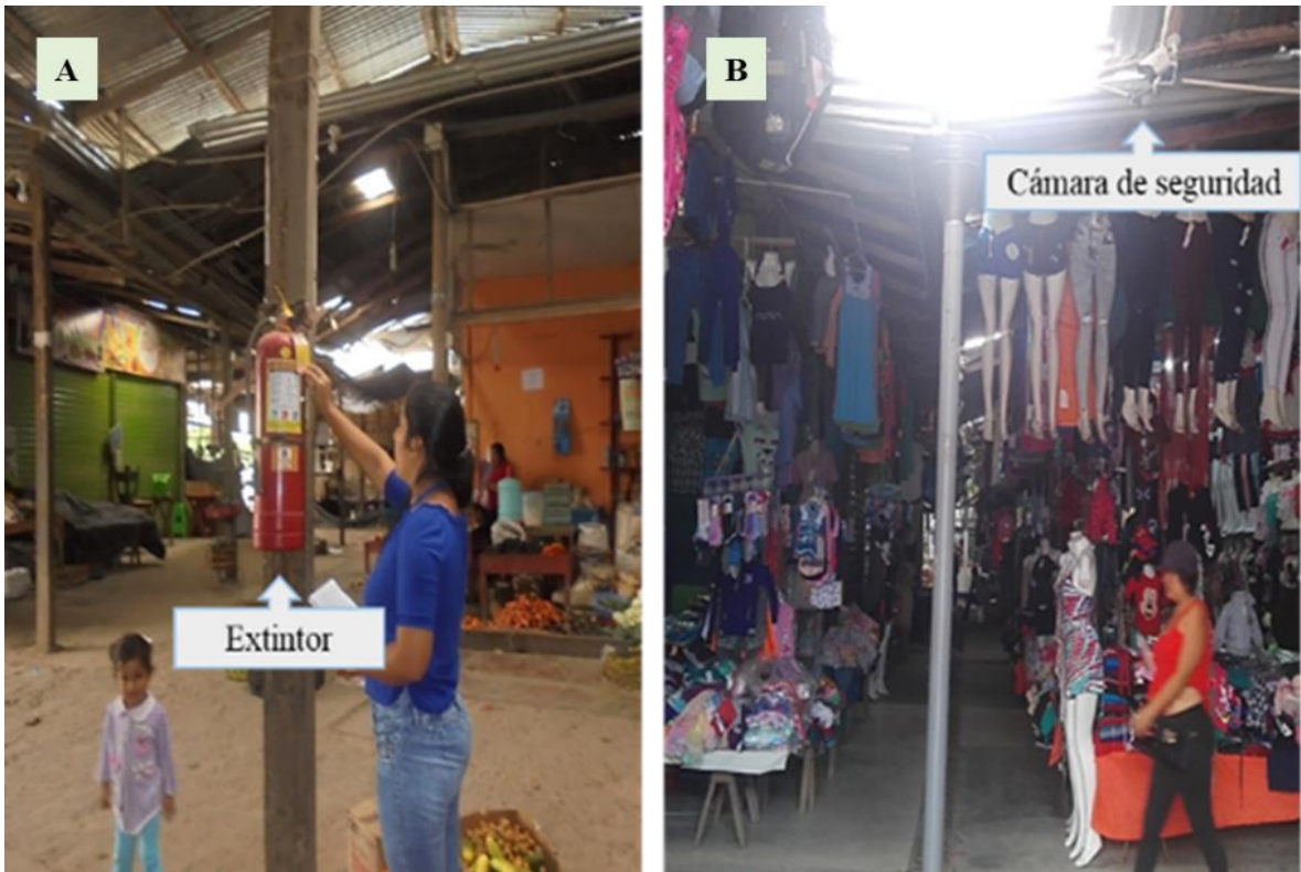
Figura 26. Identificación de extintor (A) y cámara de seguridad (B), parte interna del mercado José Olaya. Fuente: Elaboración propia.
