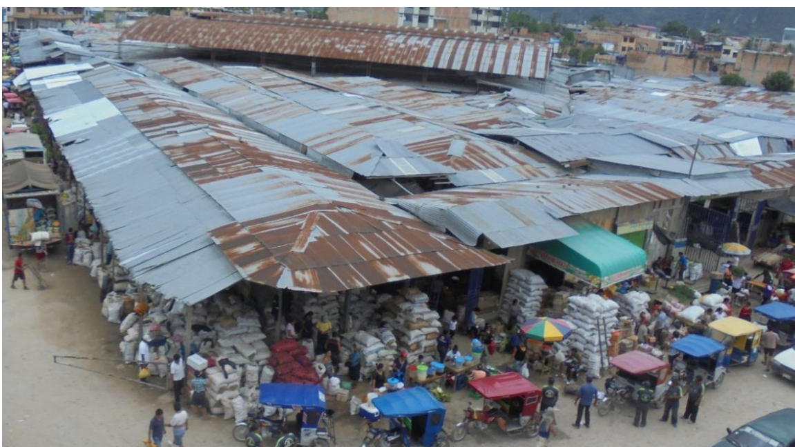
Figura 7. Infraestructura del mercado José Olaya, 2018. Fuente: Elaboración propia.
