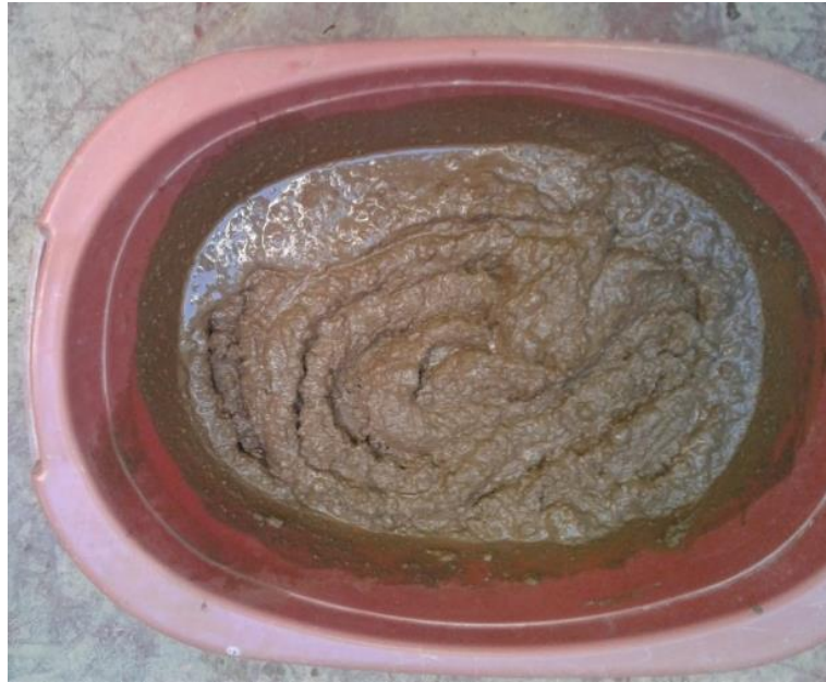
Figura 51. Preparación del barro para un bloque de adobe (Fuente; Propia, fotografía del barro)
