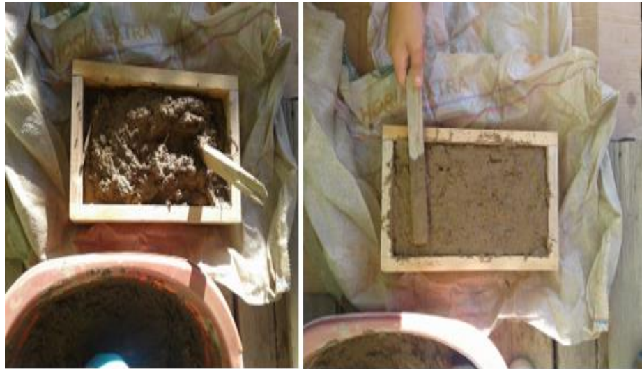
Figura 53. Proceso de moldeo de la mezcla (Fuente; Propia, fotografía del proceso de moldeo)
