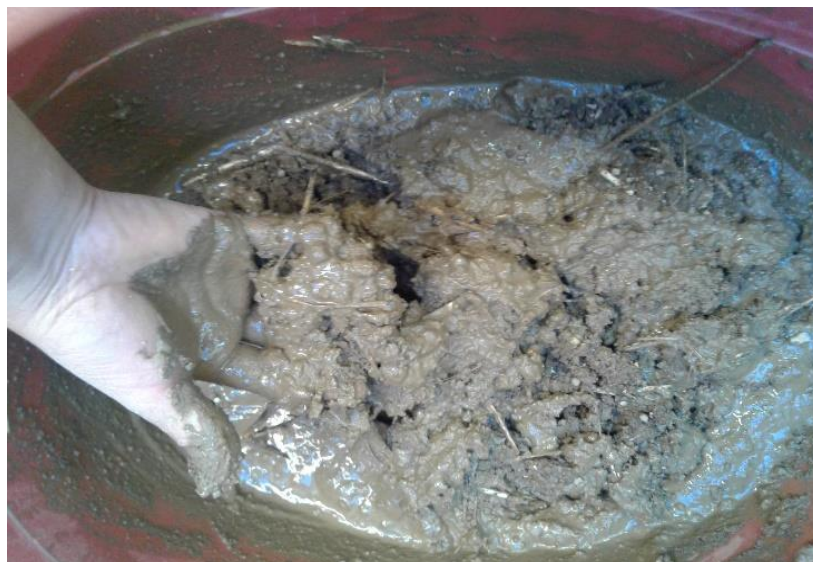
Figura 52. Mezclado de los componentes del adobe (Fuente; Propia, fotografía de la mezcla del adobe)
