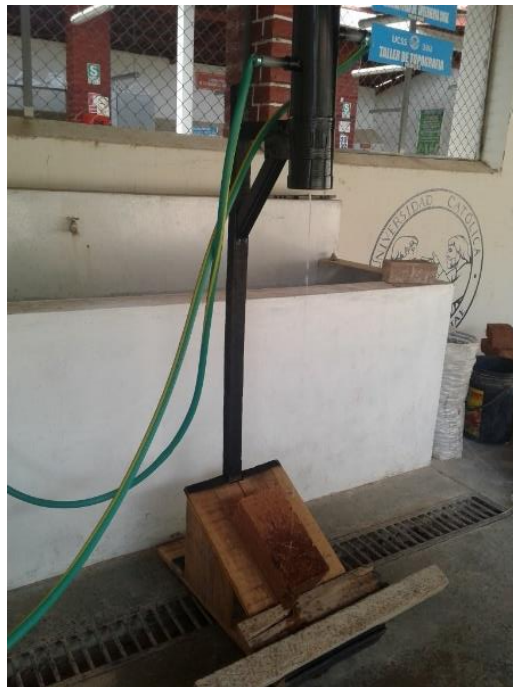
Figura 98. La construcción del equipo de Ensayo de Erosión Acelerada similar al de Swinburne (SAET) (Fuente; Propia, fotografía de la construcción del equipo del ensayo de Erosión Acelerada similar al de Swinburne (SAET))
