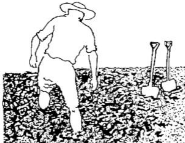
Figura 16. Mezclado de los componentes del adobe (Fuente; Imagen recopilada del Manual para la construcción de viviendas de adobe 1993)
