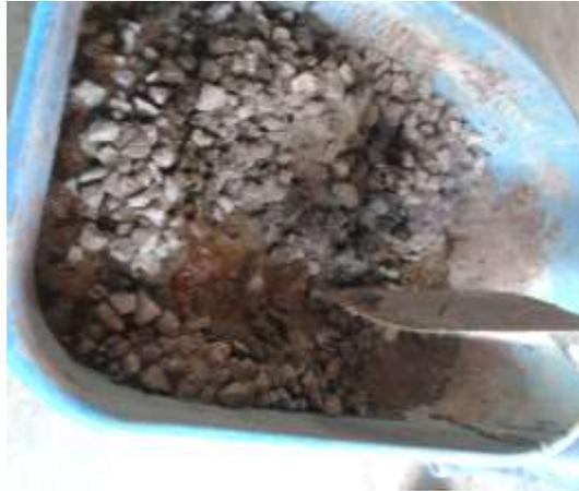
*Figura 29* Proceso de mezclado de agregado con cemento
