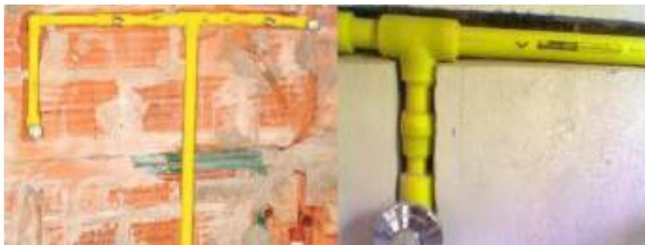
*Figura 8.* Instalación interna empotrada.
