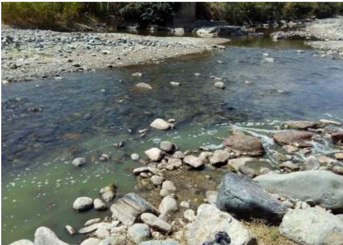
Zona de descarga al río Quiroz de la PTAR de la ciudad de Paimas
