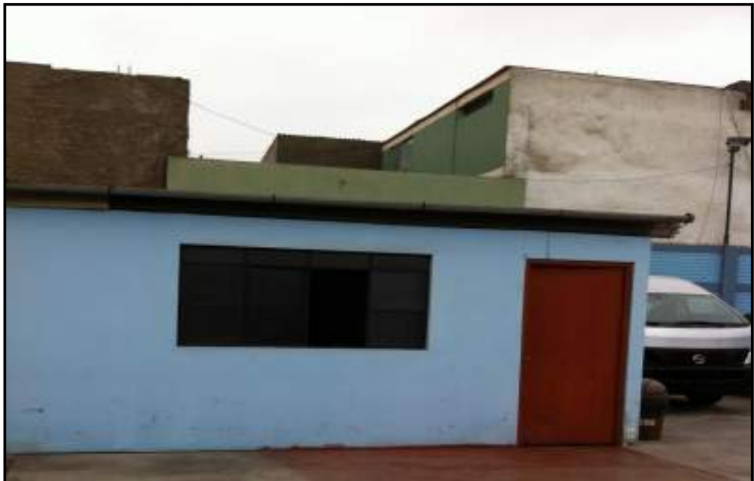
Ilustración 10: Exterior de los ambientes de la sede “la Losa”
