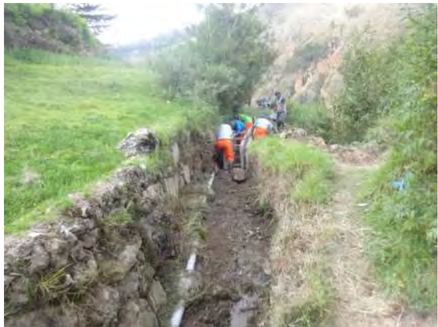
Figura 2. Tubería de desagüe conectada al canal de irrigación Huariaca.
