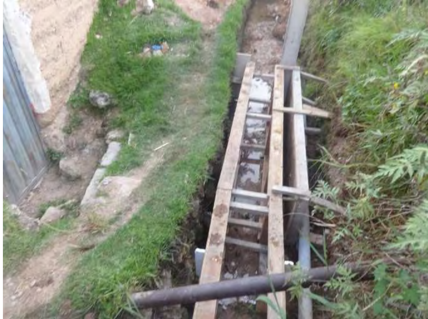
Figura 1. Tubería de desagüe conectada al canal de irrigación Carhuacatac
