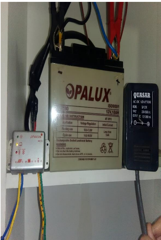
Imagen N°15. Batería y regulador solar
