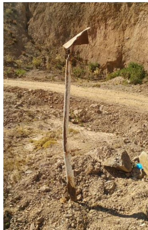
Figura 19. Chimeneas en mal estado
