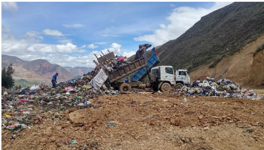
Figura 12. Recepción y descarga de residuos sólidos en el relleno sanitario Pampaya
