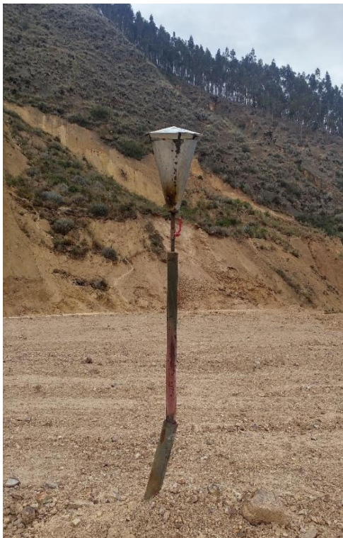
Figura 18. Chimeneas en buen estado
