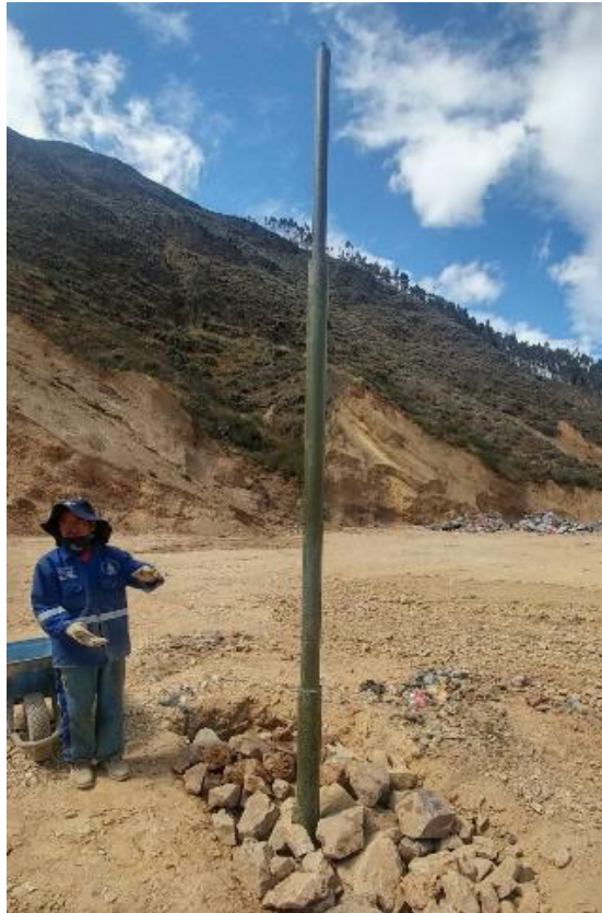
Figura 17. Colocación empírica de las chimeneas en el relleno sanitario Pampaya
