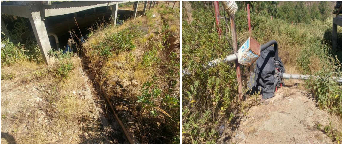
Figura 16. Canal de concreto (izquierda) y bomba de recirculación de lixiviados (derecha)
