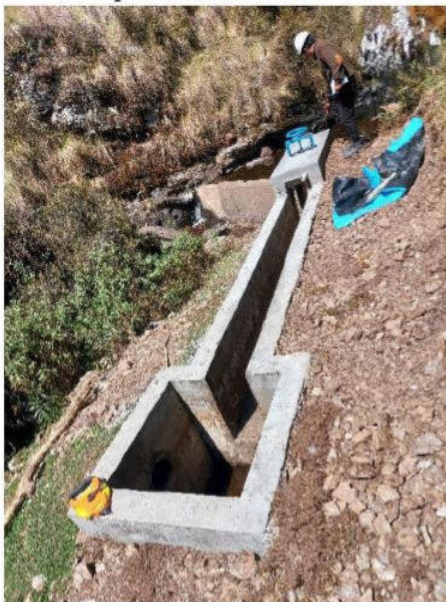
Figura 1. Estructura existente y Ejecutadas en Captación Muchanacucha
