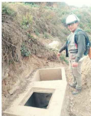
Figura 2. Se aprecia una de las Cámaras Rompe Presión en Carretera-sin Accesorios.
