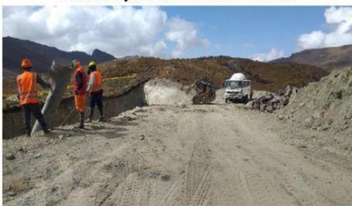
Figura 1. En el fondo se aprecia la roca existente ya totalmente excavado.
