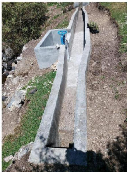
Figura 3. Estructura existente y Ejecutadas en Desarenador Aliviadero Muchanacucha y Palcacancha
