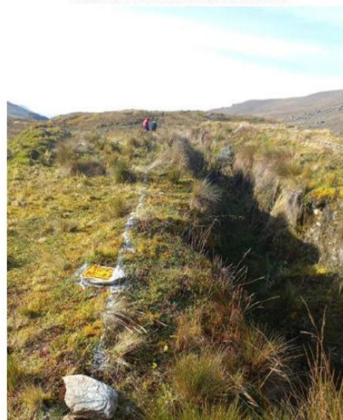
Figura 2. Se Verifica en foto adjunto una parte del tramo L con excavación superficial existente hasta la roca al otro extremo.
