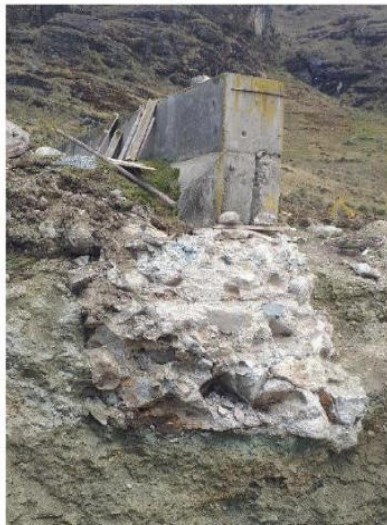
Figura 2. Se aprecia una de las Cámaras Rompe Presión en Carretera-sin Accesorios.
