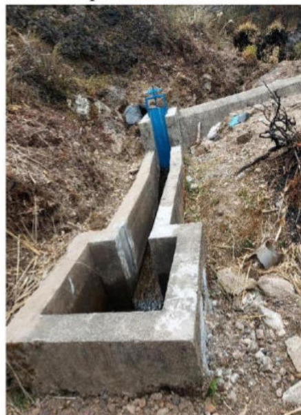
Figura 2. Estructura existente y Ejecutadas en Captación Palcacancha
