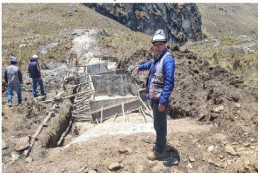
Figura 2. Zona de Ubicación de una parte de la Presa y Aliviadero Yanacocha donde se aprecia la roca existente a poca profundidad, que reduce las excavaciones y volumen de concreto.
