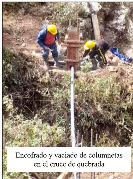
Encofrado y vaciado de columnetas en el cruce de quebrada
