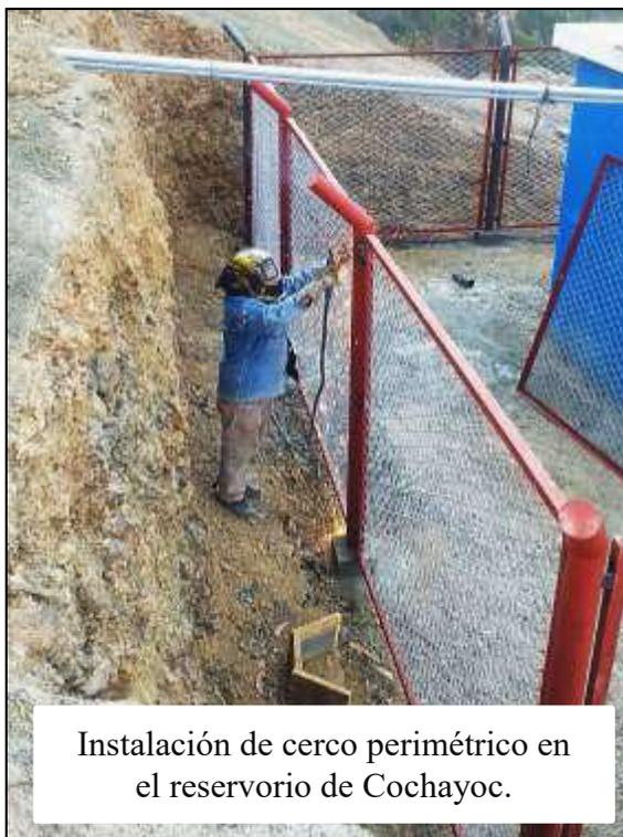
Instalación de cerco perimétrico en el reservorio de Cochayoc.
