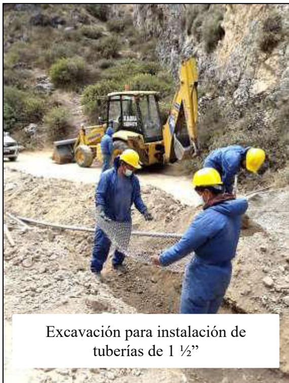
Excavación para instalación de tuberías de 1 ½"
