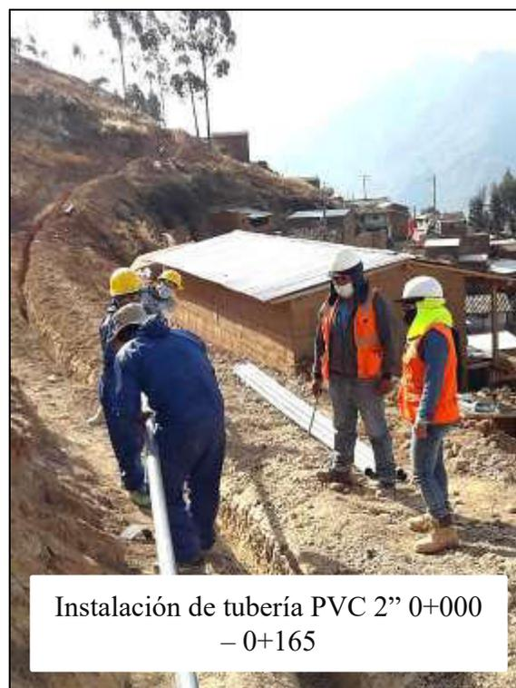
Instalación de tubería PVC 2" 0+000
