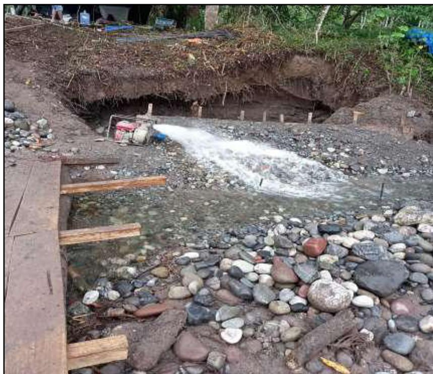
*Nota.* Se observa el bombeo de agua y el puente provisional de madera
