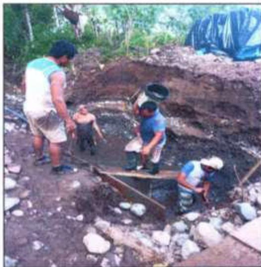
CON FECHA 17-04-2023 SE EVIDENCIA ELIMINACION DE AGUA Y MATERIAL PRODUCTO DE DESPRENDIMIENTO DE SUELO EN ZAPATA N° 2.
