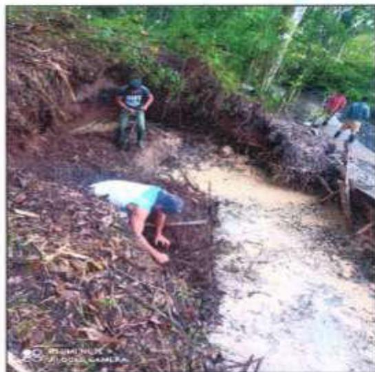
**CON FECHA 17-04-2023 SE EVIDENCIA DESPRENDIMIENTO DE SUELO DURANTE LA EXCAVACION EN ZAPATA N° 1.**
