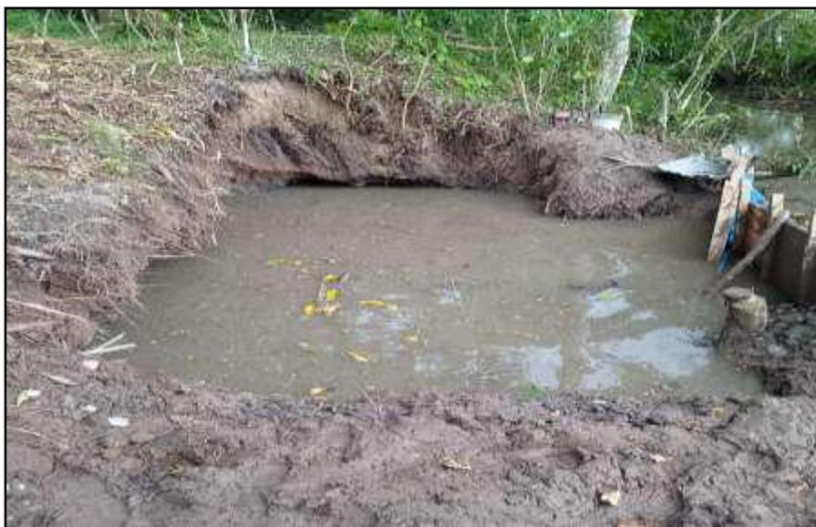
*Nota.* Se observa la presencia de abundante agua en la excavación de zapatas.
