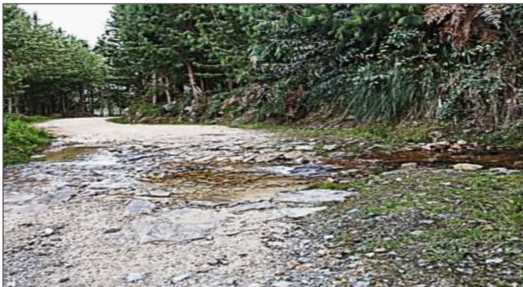
Imagen 9. Badén de Tierra (A=5m L=7m), en la progresiva 02+375 km
