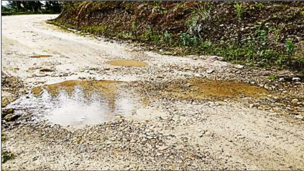
Imagen 5. Punto crítico cruce de agua en la progresiva 00+739 km
