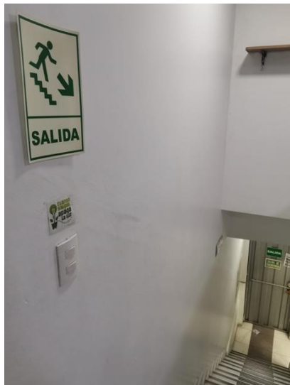
Foto 3: Señalización de salida por las escaleras
