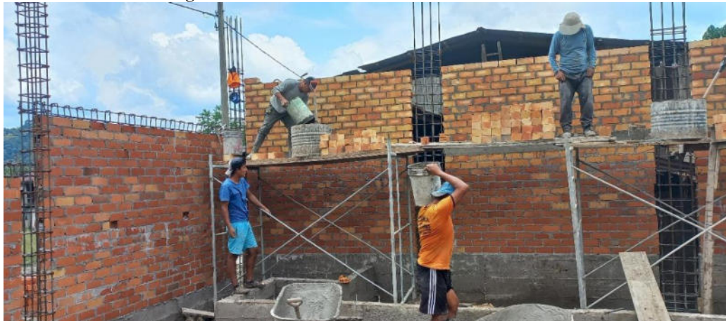
Asentado de ladrillo muro de soga
