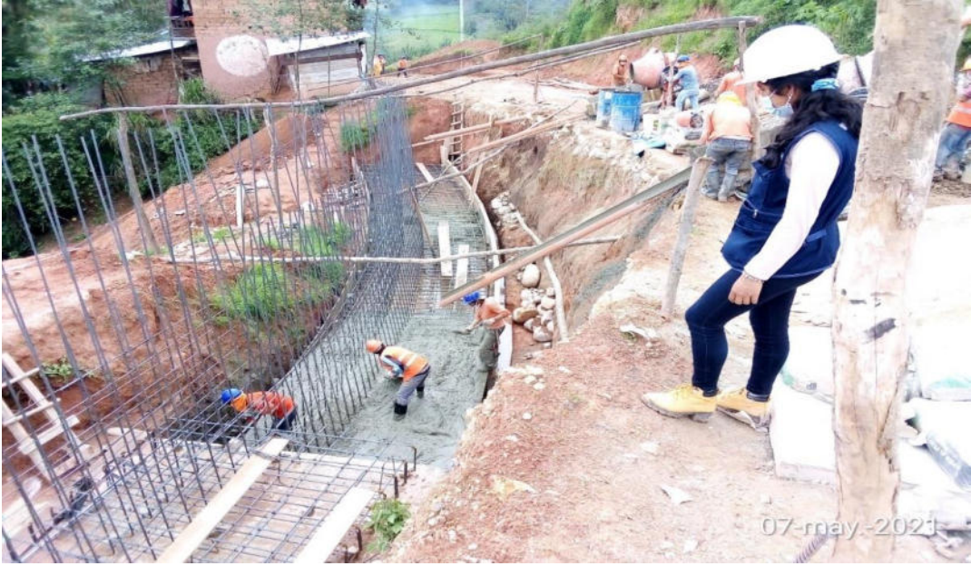
ANEXO 09. Ejecución de muro de concreto armado y sus mayores metrados
