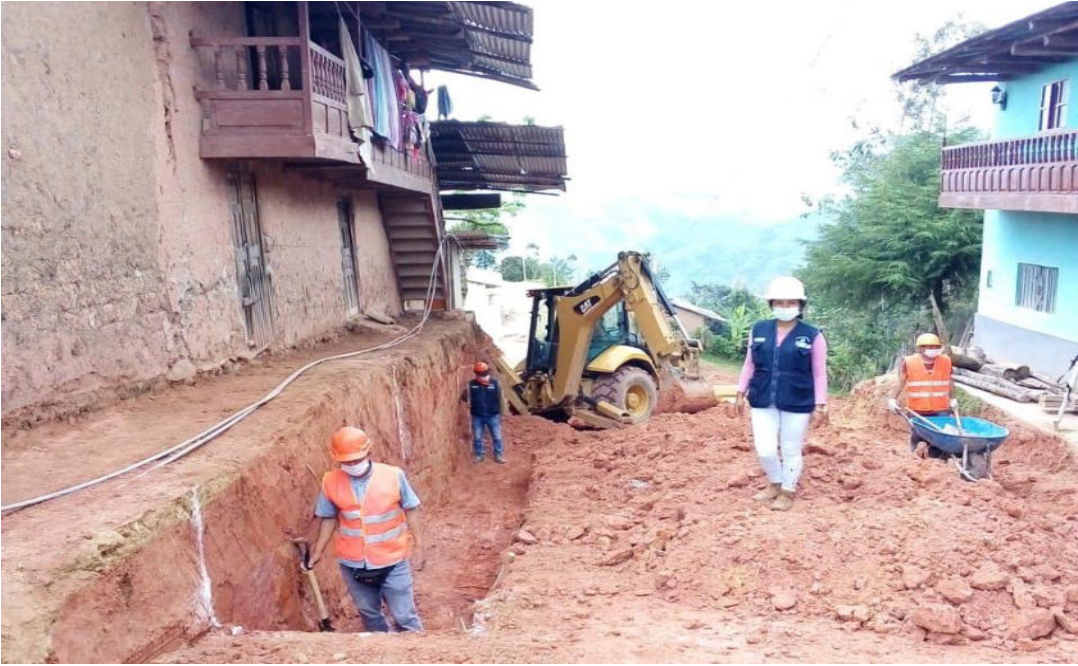
ANEXO 08. Ejecución de partidas adicionales de obra, muro de concreto armado.
