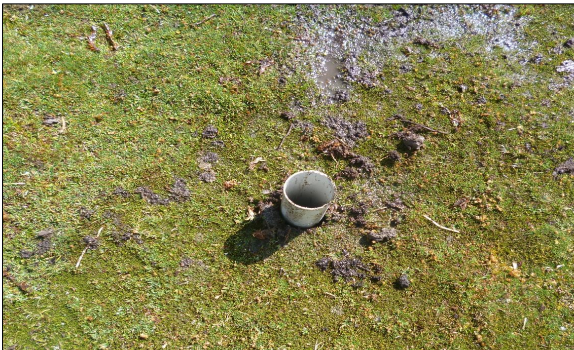
Figura 11. Instalación de los pozos de monitoreo en el bofedal Piticocha Bajo – RPNYC. Fuente: Elaboración propia.
