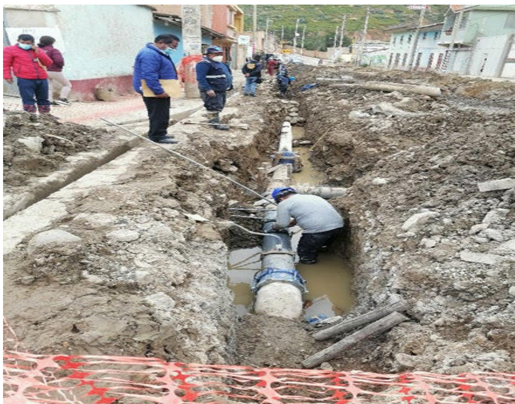
Cambio de Red de Agua
