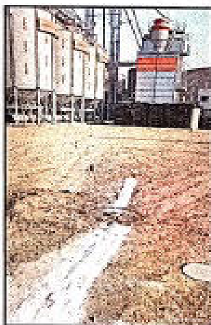
FOTO N° 08: Vista del vértice en tubo de concreto y varilla de 3/8".
