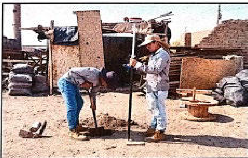
FOTO N° 02: Vista del personal realizando el hueco para la elaboración del hito que contendrá el vértice.
