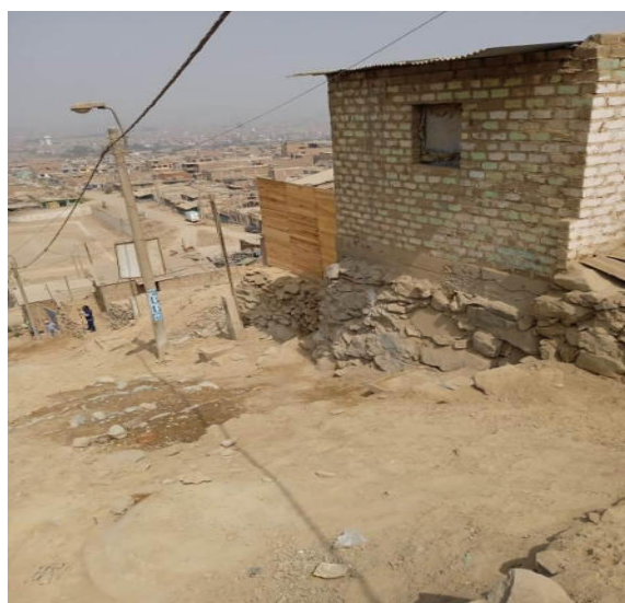
Viviendas con Pircas en el A.H.
