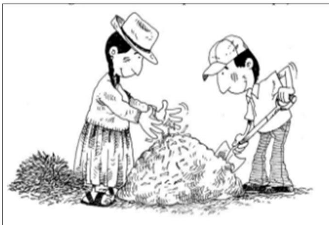
*Nota.* Mezcla de barro con paja. Adaptado de “Manual de construcción con adobe reforzado con geomallas de viviendas de bajo costo saludable y seguras” (p.24), por Blondet, et al., 2010.
