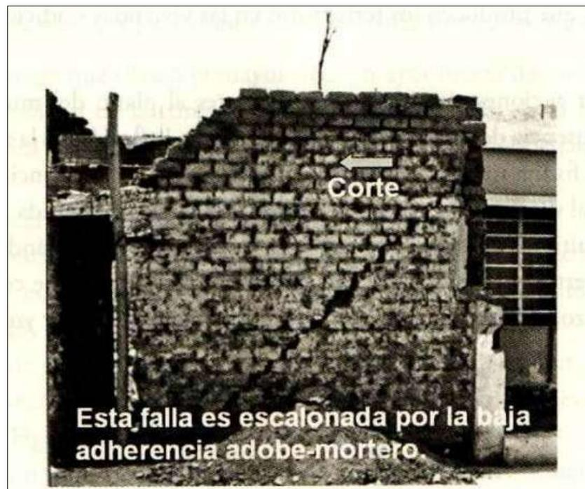
*Nota.* Falla producida por cargas sísmicas coplanares por la poca adherencia entre el mortero y el adobe. Adaptado de “Diseño y Construcción de Estructuras Sismorresistentes de Albañilería” (p. 319), por San Bartolomé et al., 2018.
