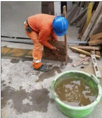
*Nota.* Bloques de adobes asentados con una junta de 1,5 cm de espesor. Archivo fotográfico propio, 2021.
