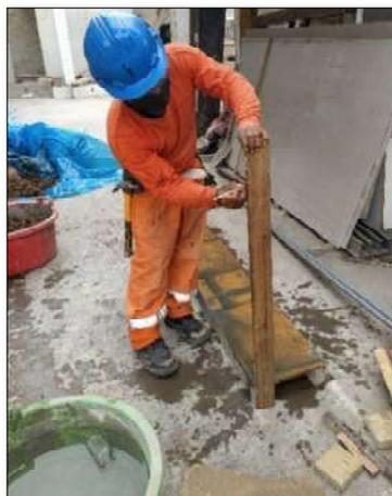
*Nota.* Colocación de escantillón en bases de madera y herramientas humedecidas para construcción de pilas. Archivo fotográfico propio, 2021.
