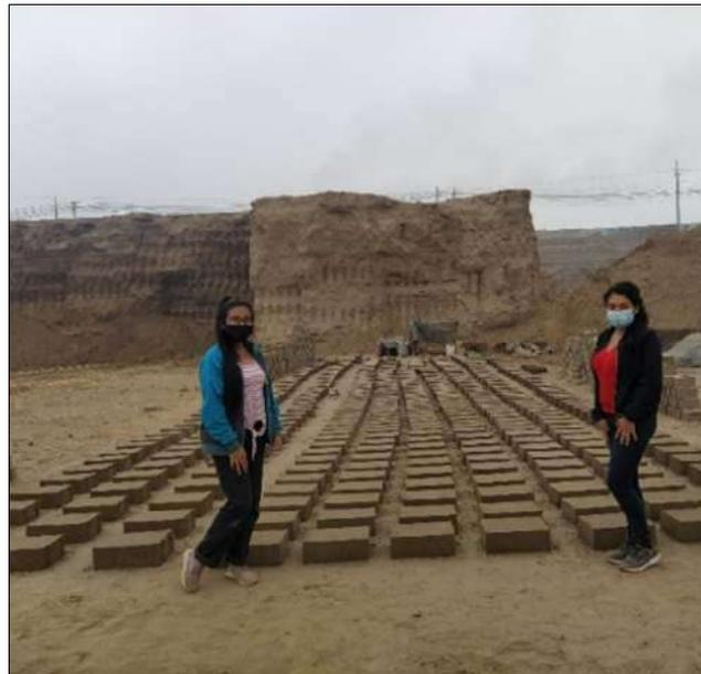
*Nota.* Hileras de bloques de adobe reforzados con fibras diagonales de Arundo Donax cubiertos con arena fina para su respectivo secado. Archivo fotográfico propio, 2021.
