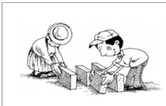
*Nota.* Colocación en canto. Adaptado de “Manual de construcción con adobe reforzado con geomallas de viviendas de bajo costo saludable y seguras” (p.27), por Blondet, et al., 2010.
