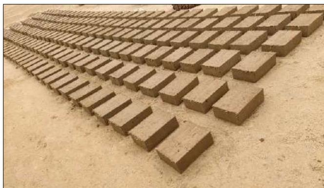
*Nota.* Hileras de bloques de adobe sin refuerzo cubiertos con arena fina para su respectivo secado. Archivo fotográfico propio, 2021.
