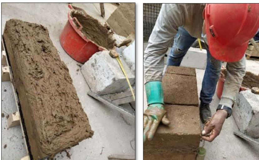
*Nota.* Bloques de adobes asentados con respectivas juntas de mortero de 1,5 cm de espesor para muretes. Archivo fotográfico propio, 2021.
