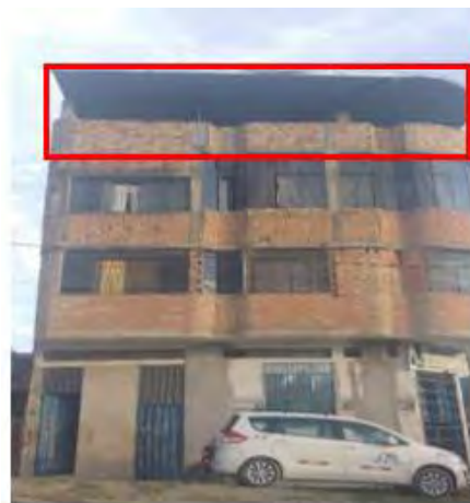
Figura 11. Vivienda de albañilería confinada con techo final de calamina. Fuente: Elaboración propia.
