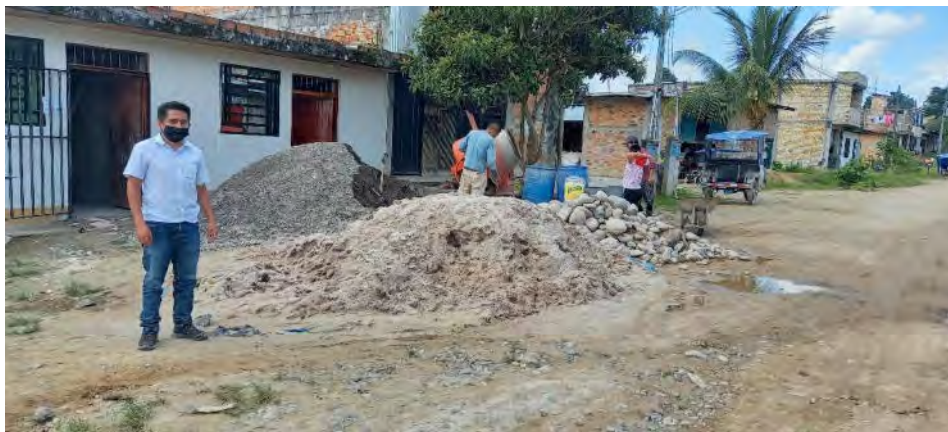
Figura 3. Hormigón, arena fina y piedra grande usado en construcción de vivienda.
