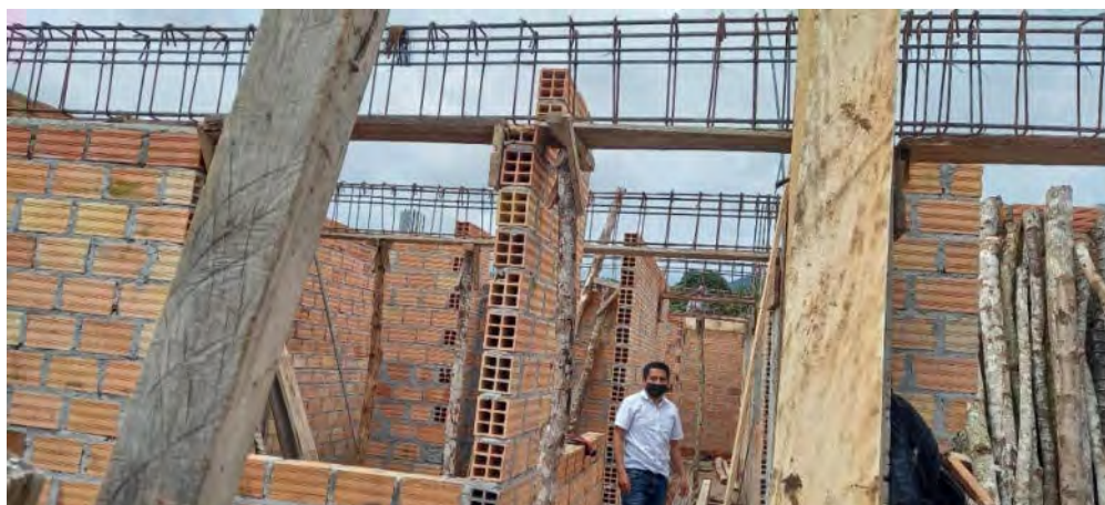
Figura 8. Uso de ladrillo pandereta en muros portantes y no portantes de viviendas. Fuente: Elaboración propia.
