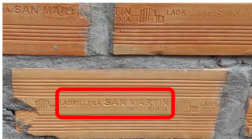
Figura 9. Ladrillo pandereta elaborado en Ladrillera San Martín. Fuente: Elaboración propia.
