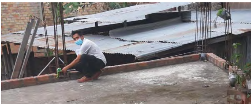
Figura 55. Medición de la sección y separación de columnas (V-34).
