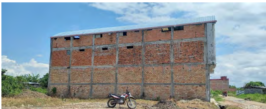
Figura 14. Vivienda multifamiliar sin confinamiento de sus columnas en el último piso. Fuente: Elaboración propia.
