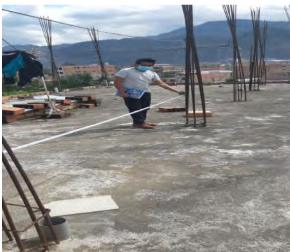
Figura 62. Medición de distancia entre elementos estructurales de V-34.
